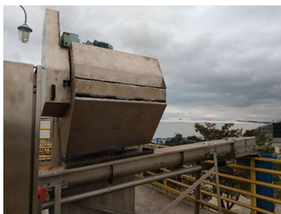
Figura 87 Rosca sem-fim utilizada para remoção da areia na ETE Central (16/09/2021).
