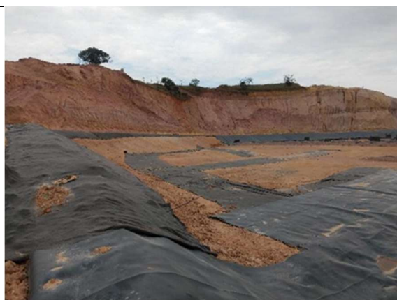
Figura 63 aterro sanitário em operação – impermeabilização da base (15/09/2021).
