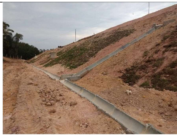
Figura 60 aterro sanitário em operação – sis- tema de drenagem pluvial (15/09/2021).
