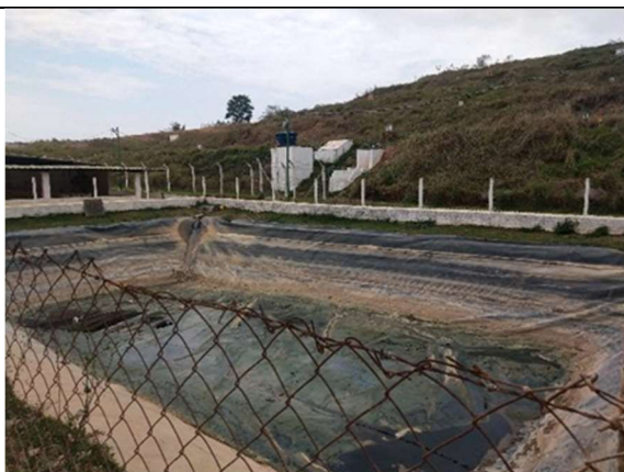
Figura 57 aterro sanitário encerrado - lagoa de estabilização do percolato (15/09/2021).
