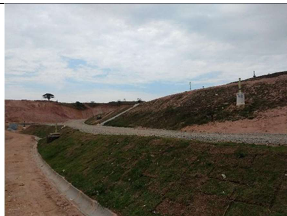
Figura 62 aterro sanitário em operação - berma e sistema de drenagem (15/09/2021).
