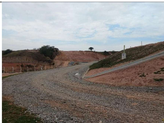
Figura 61 aterro sanitário em operação – sistema de drenagem pluvial e via de acesso interno (15/09/2021).
