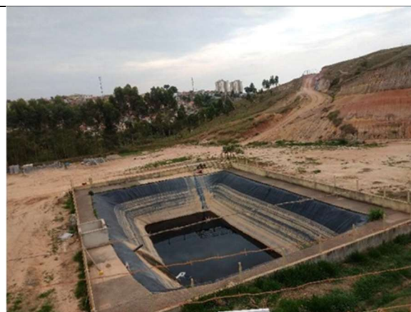
Figura 66 aterro sanitário em operação - lagoa de estabilização do percolato (15/09/2021).
