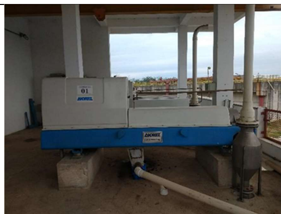
Figura 90 Centrifugas utilizadas no desaguamento do lodo na ETE Central (16/09/2021).
