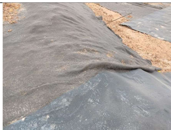
Figura 64 aterro sanitário em operação – impermeabilização da base (15/09/2021)
