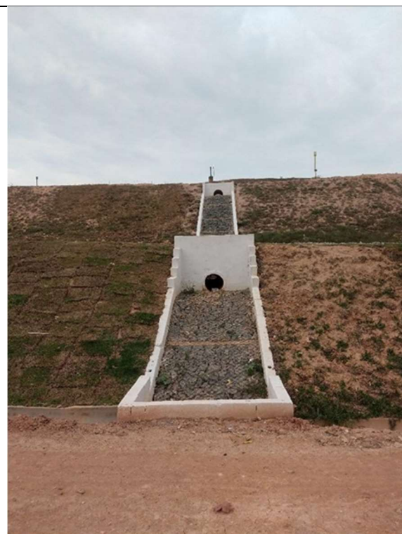
Figura 65 aterro sanitário em operação - sistema de drenagem de água superficial (15/09/2021).
