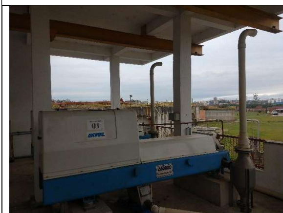
Figura 91 Centrifugas utilizadas no desaguamento do lodo na ETE Central (16/09/2021).
