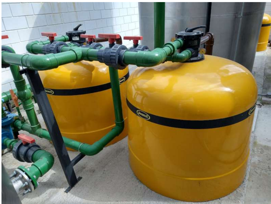
Foto 28 Filtros de areia para o polimento do efluente dos decantadores secundários
