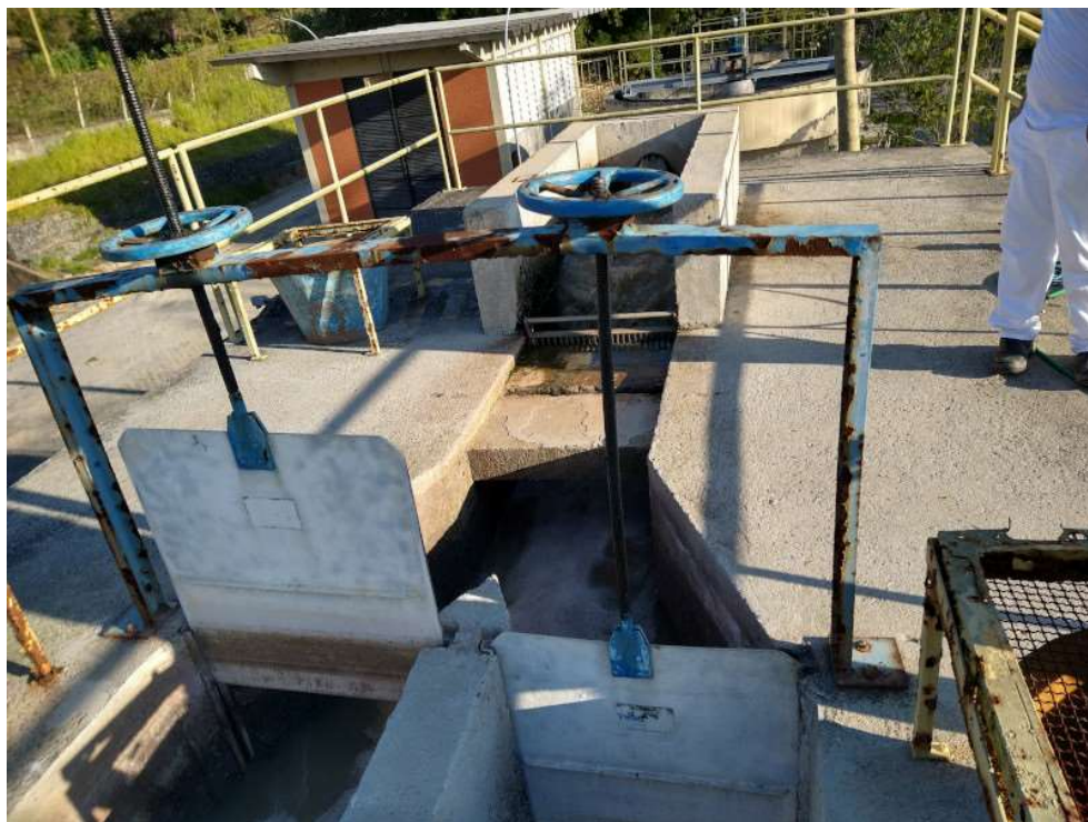
Foto 19 Vista parcial do tratamento preliminar. Em primeiro plano comportas de entrada nas caixas de areia e ao fundo canal de chegada do esgoto bruto e gradeamento
