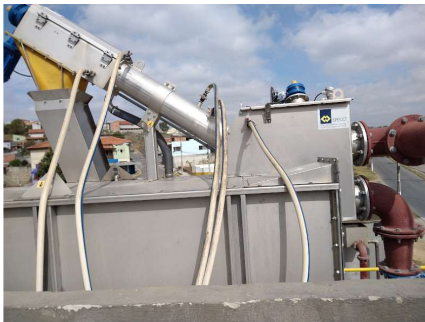
Foto 26 Vista da estação compacta de tratamento preliminar, peneira e caixa de areia de limpeza mecanizada.
