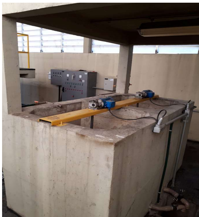
Foto 25 Tanques de preparo da emulsão de polímero. Ao fundo, quadros de energização e comando
