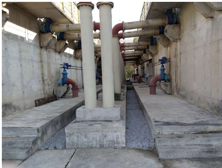
Foto 3 Vista das paredes laterais de dois reatores UASB, com destaque para os tubos de alimentação e coleta de lodo e espuma
