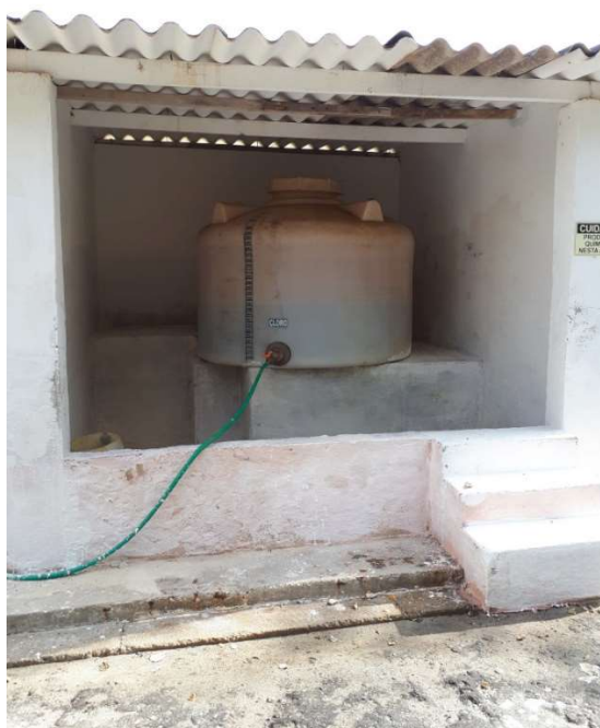
Foto 13 Tanque estacionário de armazenamento da solução de hipoclorito de sódio
