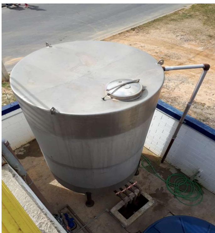
Foto 29 Tanque de armazenamento de lodo descartado
