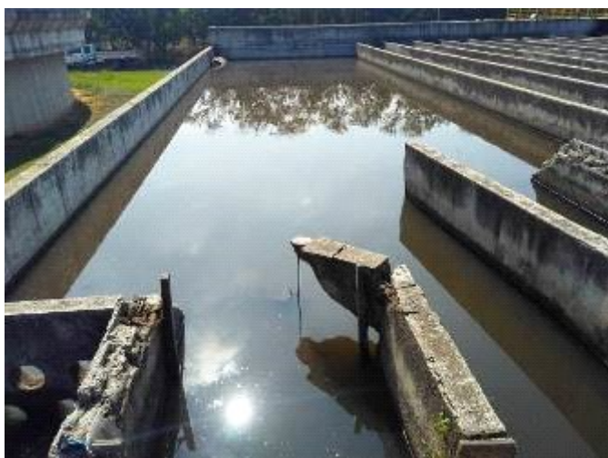
Foto 43 ETE Central - TC - muro final da chicana
