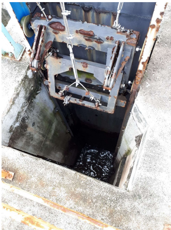
Foto 33 Vista do poço de chegada de esgoto
