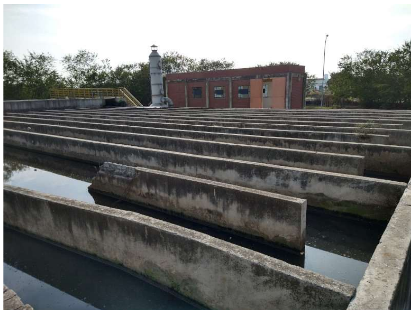
Foto 8 Vista da câmara de contato de desinfecção do efluente tratado. Ao fundo, torre de neutralização de gás cloro e prédio de abrigo de dosadores e cilindros de gás cloro (desativados)
