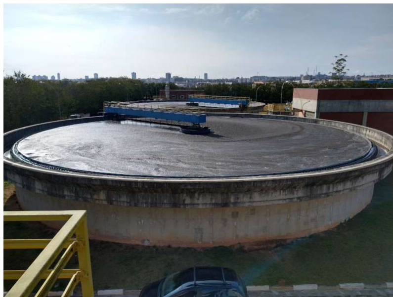
Foto 5 Vista de um dos decantadores secundários do estágio de Lodos Ativados
