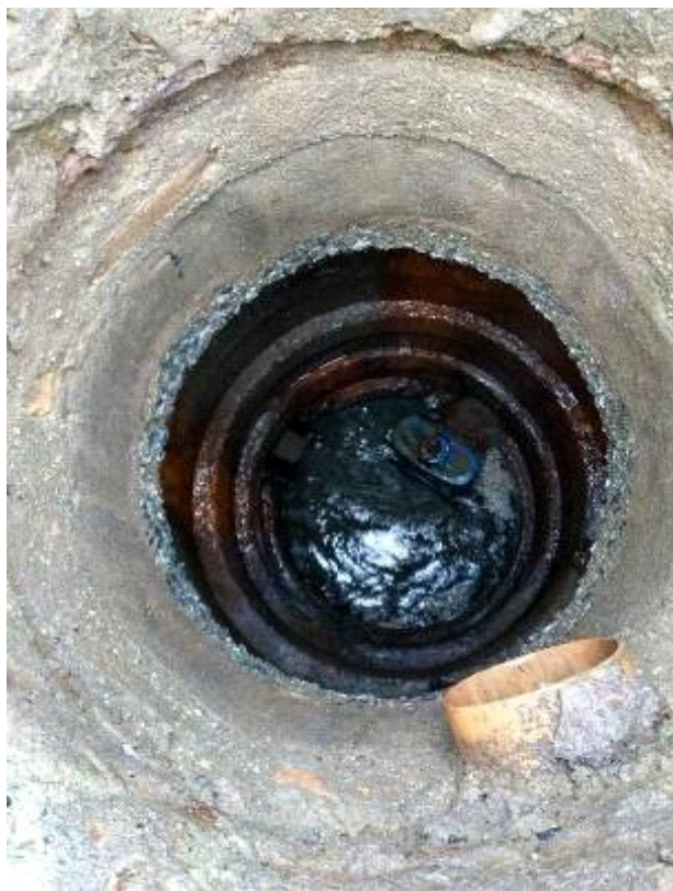
Foto 38 EEE 24 - Caixa com registro emperrado
