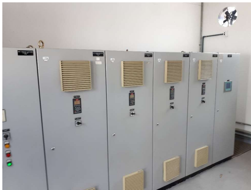
Foto 35 Quadros elétricos de energização e comando
