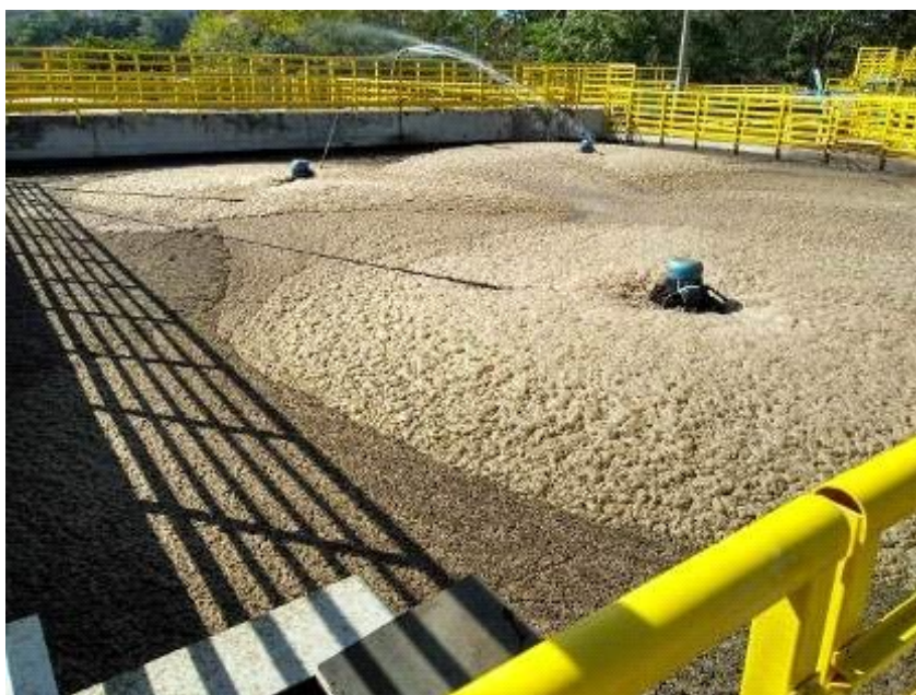
Foto 45 ETE Vila Branca - Tanques de aeração (4, dos quais 3 em operação)
