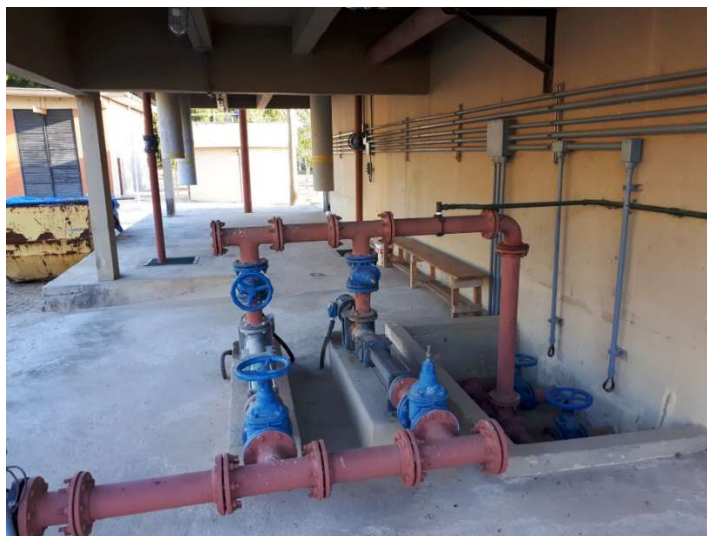
Foto 23 Vista dos conjuntos moto bomba de descarte de excesso de lodo
