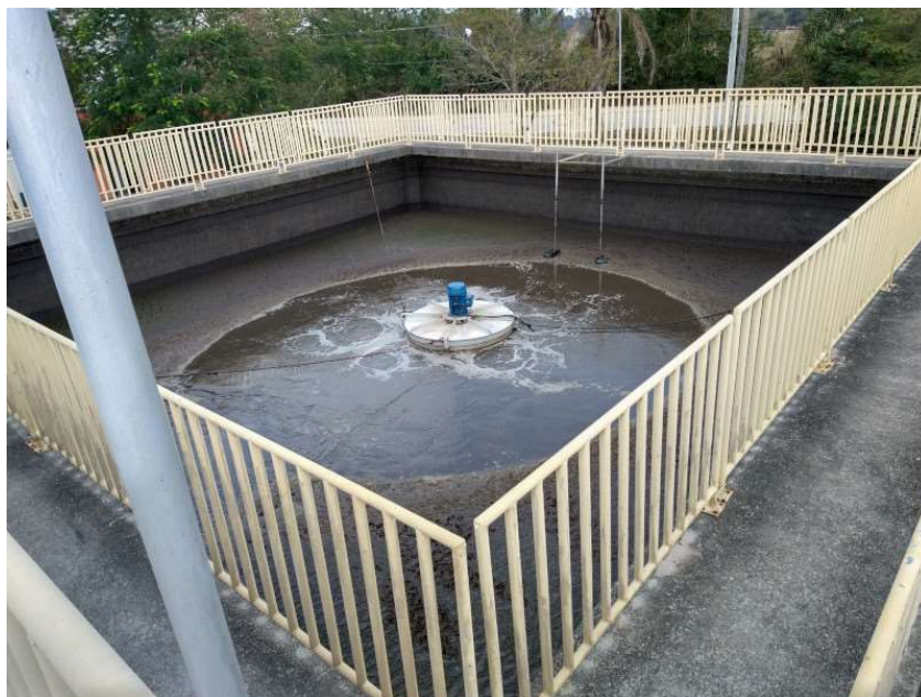
Foto 17 Vista de um dos tanques de aeração / decantação com destaque para o aerador mecânico flutuante em operação
