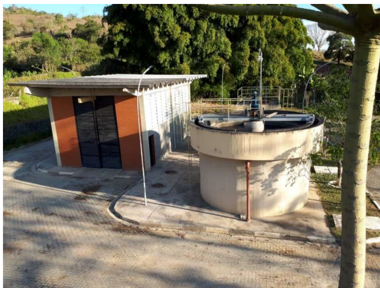
Foto 22 Vista do adensador gravimétrico de lodo descartado e prédio do sistema de desaguamento
