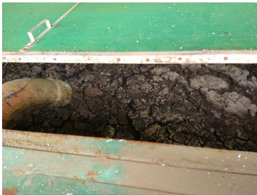
Foto 12 Vista parcial de uma das células de leito de secagem com destaque para a tela de cobertura
