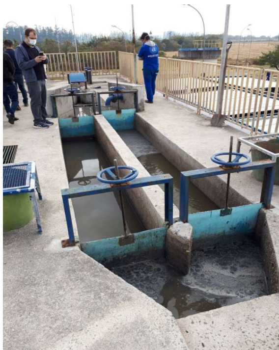
Foto 16 Vista do tratamento preliminar. Em primeiro plano, caixas de areia e, ao fundo, gradeamento.
