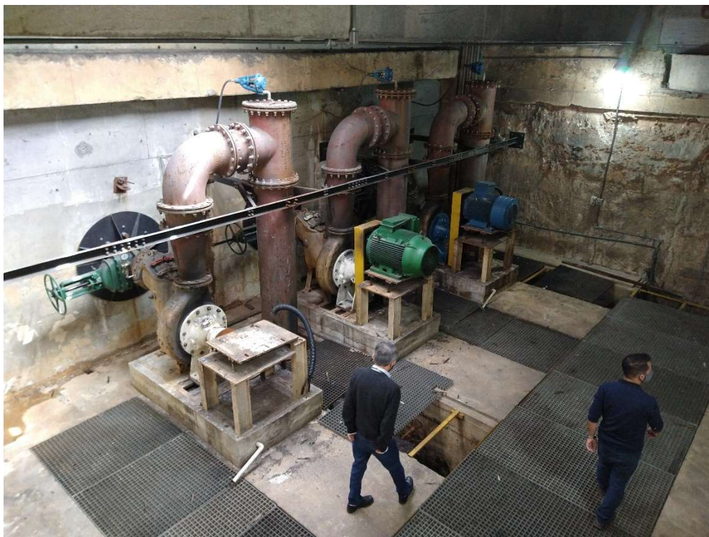
Foto 34 Poço seco com os conjuntos moto bomba centrífugos de eixo horizontal.
