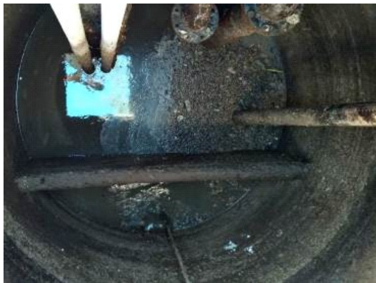
Foto 40 EEE 25 - Poço de sucção com cesto e uma bomba de recalque
