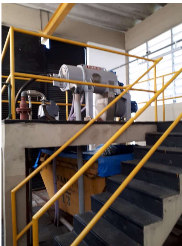
Foto 24 Vista do “decanter” centrífugo destinado ao desaguamento do lodo
