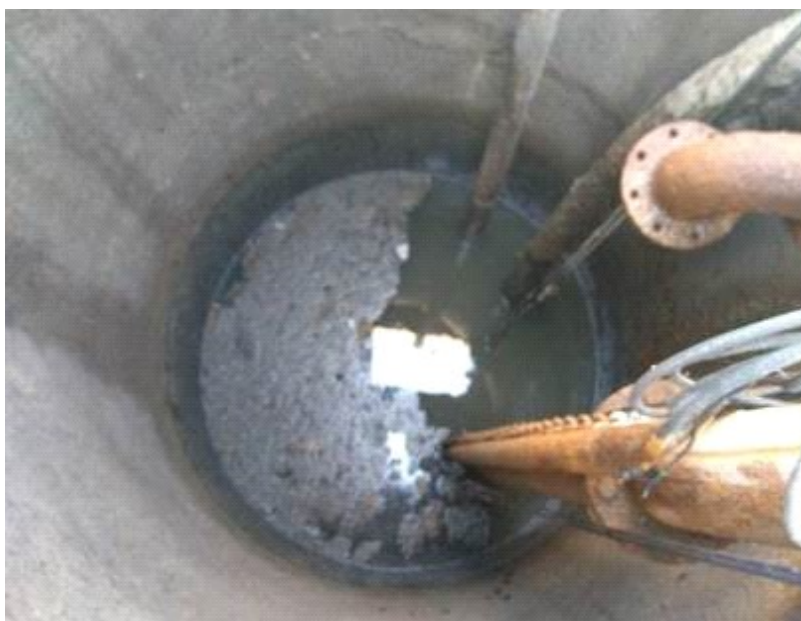
Foto 39 EEE 23 - Poço de sucção com gradeamento em cesto
