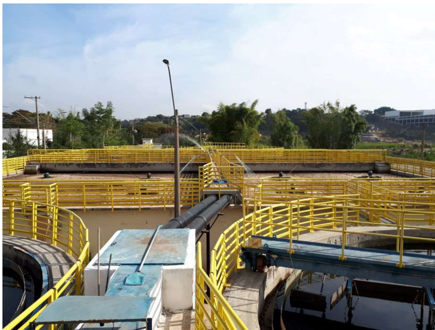
Foto 10 Vista geral do sistema de lodos ativados. Em primeiro plano decantadores secundários e ao fundo tanques de aeração
