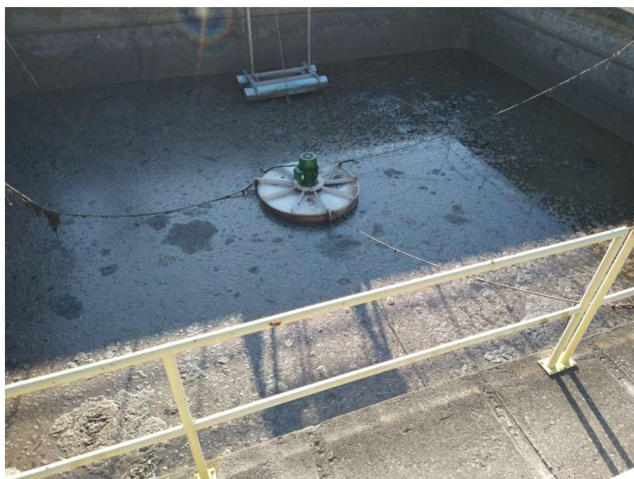
Foto 20 Vista de um dos tanques de aeração/decantação. Destaque para o aerador mecânico superficial e para a estrutura flutuante de coleta de sobrenadante
