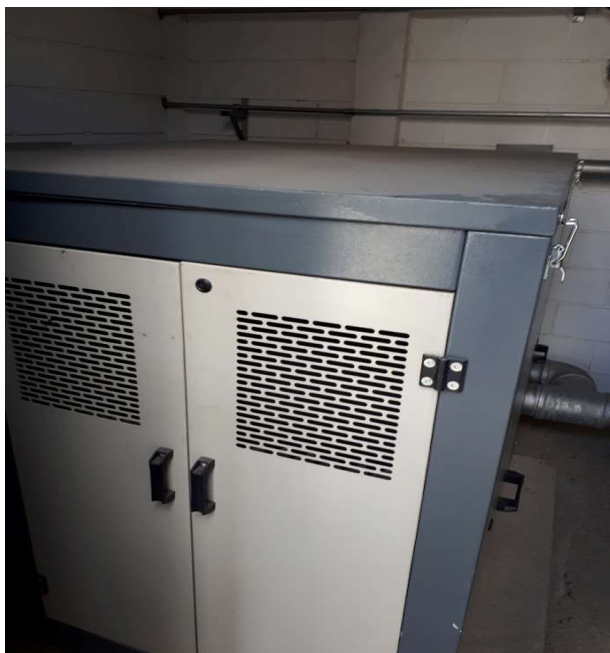
Foto 30 Vista de um dos sopradores do sistema de aeração por ar difuso (cabine acústica)
