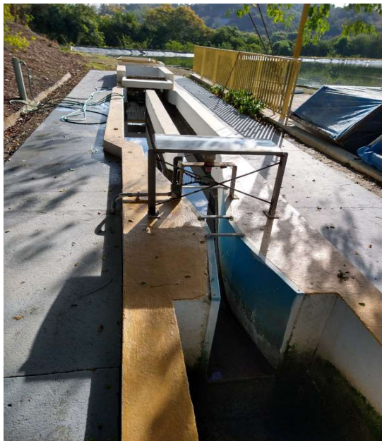
Foto 14 Vista do tratamento preliminar. Em primeiro plano, calha Parshall e ao fundo caixas de areia e grade
