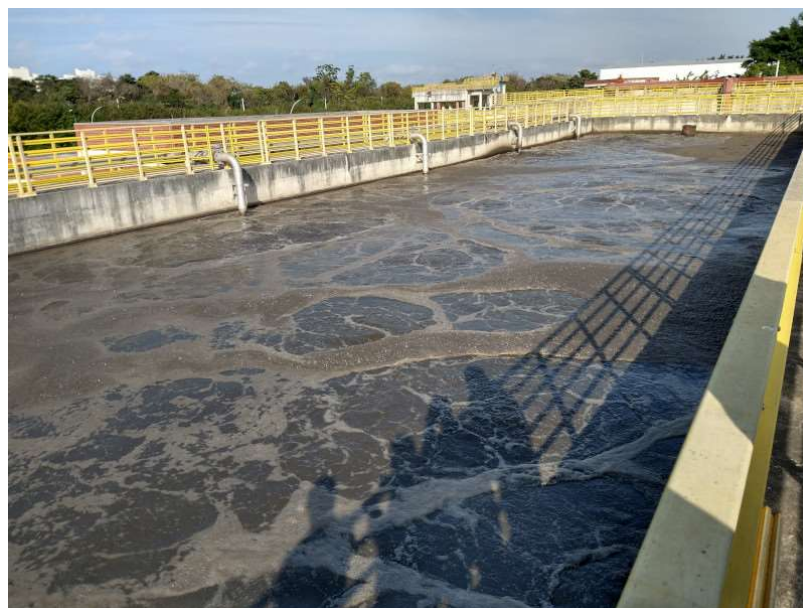
Foto 4 Vista de um dos tanques de aeração do estágio de Lodos Ativados
