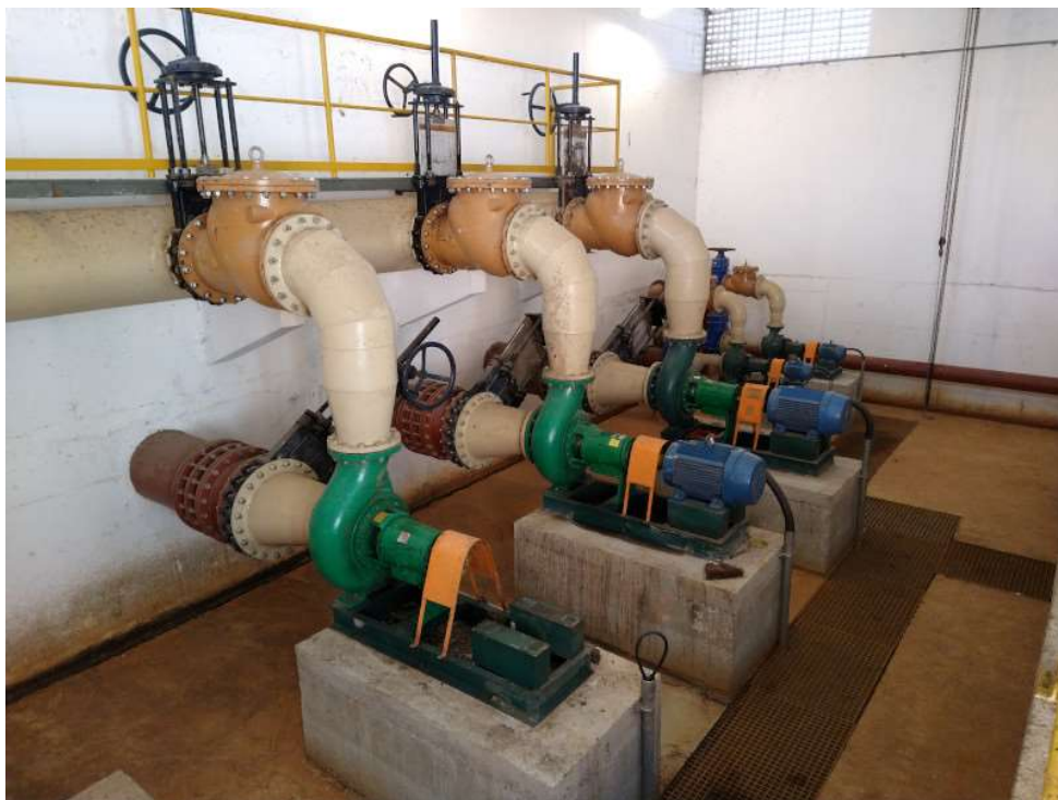
Foto 7 Poço seco da estação elevatória de recirculação e descarte de lodo ativado
