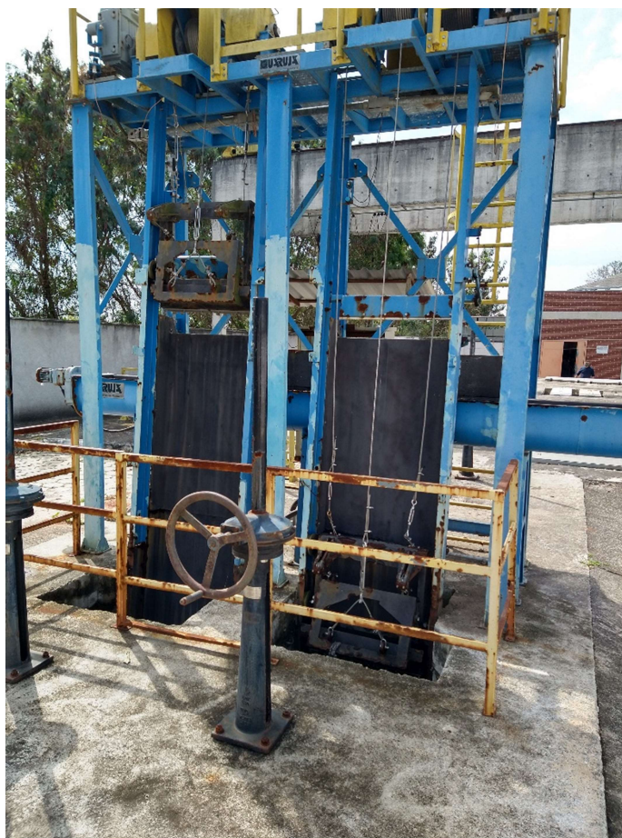
Foto 32 Sistema de gradeamento mecanizado atualmente inoperante.
