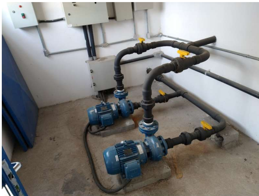
Foto 11 Vista interna da estação elevatória de recirculação e descarte de lodo ativado
