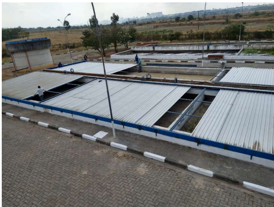
Foto 18 Vista dos leitos de secagem com cobertura retrátil
