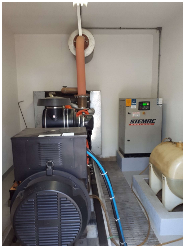
Foto 36 Sistema de energização provisória. Gerador a diesel
