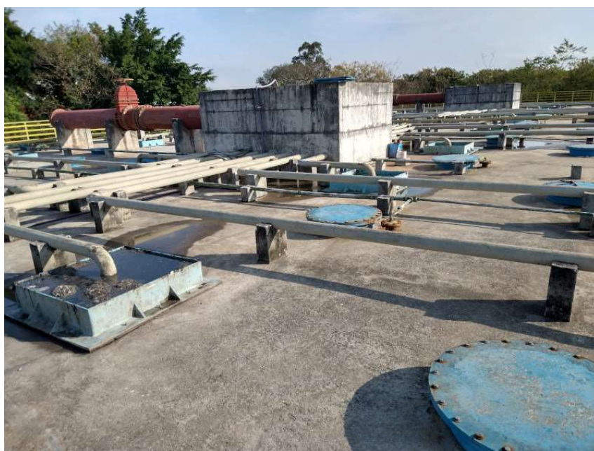
Foto 2 Laje de cobertura de um reator UASB com destaque para as caixas de distribuição de fluxo de alimentação e inspeções
