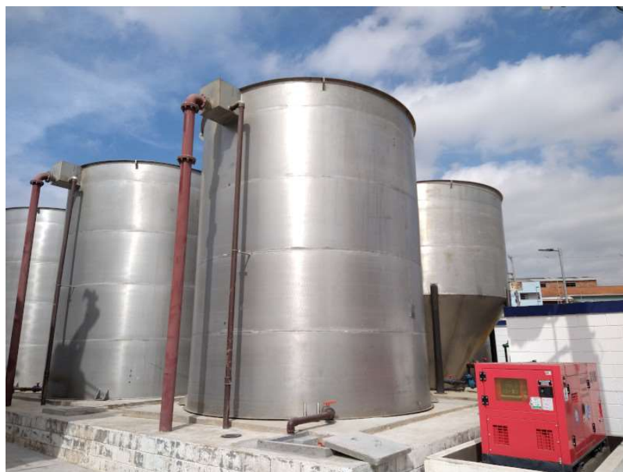
Foto 27 Em primeiro plano, tanques de aeração e no segundo plano decantadores secundários. À direita, gerador destinado à eventual energização da EE de chegada do esgoto bruto
