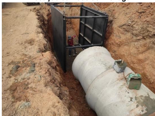
Execução da Rede de Drenagem
