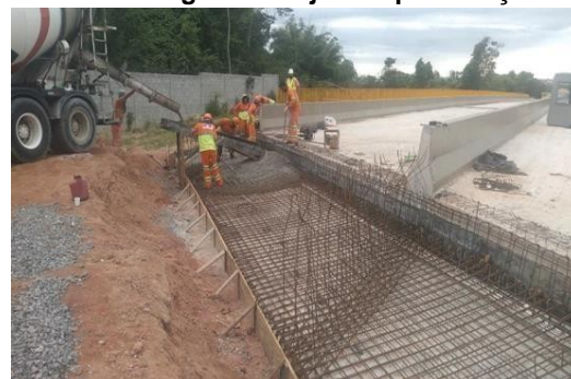
Execução da Montagem da Forma, Armação e Concretagem da Laje de Aproximação
