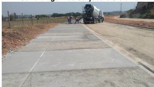
Concretagem de Calçada e Ciclovia
