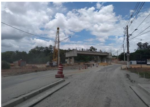
Pavimentação – Lançamento de BGS Estacas
