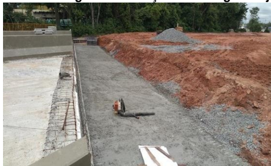
Base Montagem da Armação de Ferragem Laje
