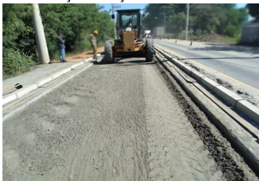
Pavimentação – Lançamento de BGS Estacas
