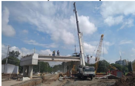
Lançamento de Pré Laje
