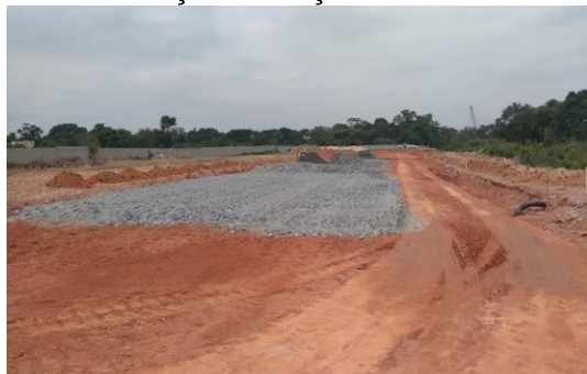
Pavimentação – Execução de Camada de BGS
