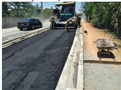
Pavimentação – Lançamento de CBUQ faixa II
