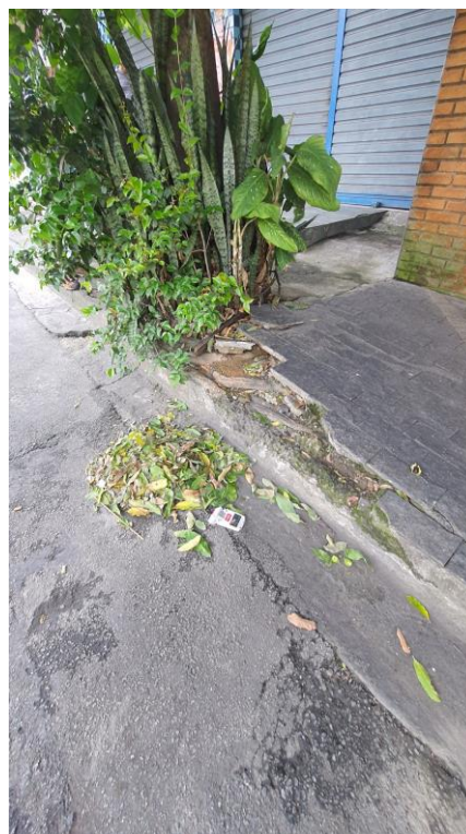
Figura 48: Exemplos de conflitos com a calçada encontrados nas ruas de Jacareí/SP.
