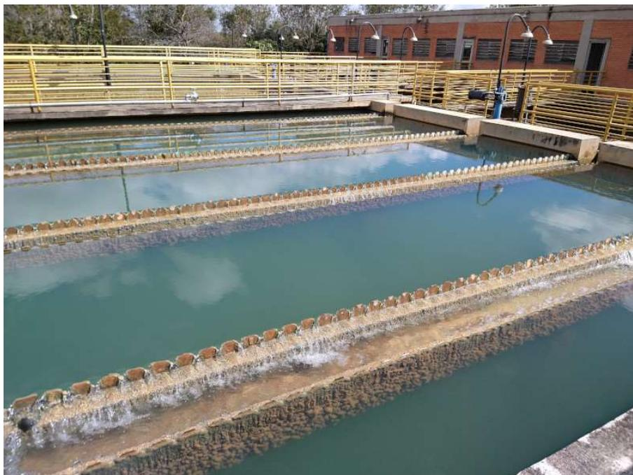
*Foto 8 Vista da porção final de um dos decantadores com destaque para as calhas de coleta de água decantada*
