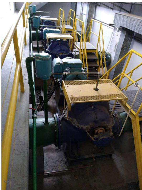
*Foto 4 vista do poço seco e conjuntos motobomba, do tipo bipartidos, da captação principal.*
