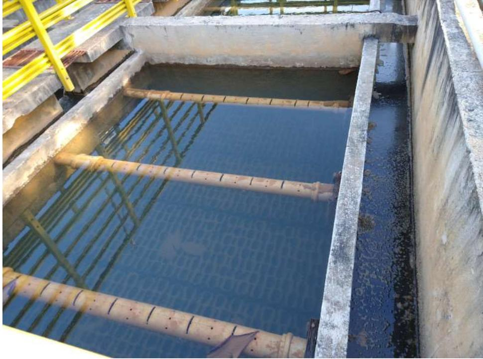
*Foto 16 Decantador de alta taxa com destaque para os módulos lamelares submersos e as tubulações perfiradas de coleta de água decantada*
