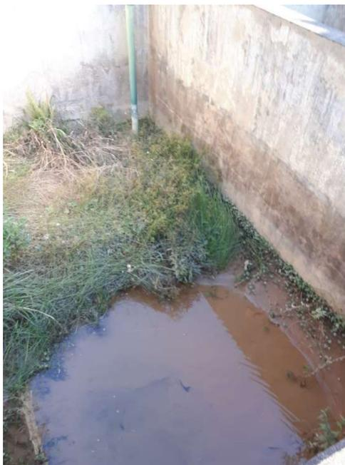
*Foto 20 Vista de um dos tanques de armazenamento de efluentes, atualmente desativado*
