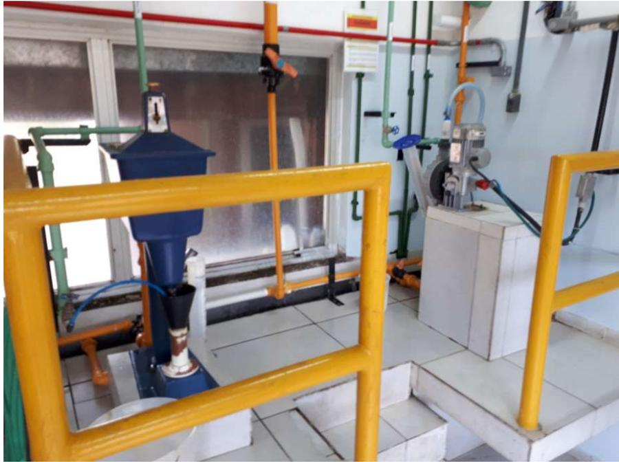
*Foto 12 A direita, dosador de nível constante de solução de sulfato de alumínio, a direita, equipamento de dosagem de reserva*
