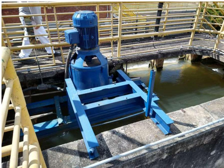
*Foto 7 Vista de um dos flocoadores mecânicos desativados*
