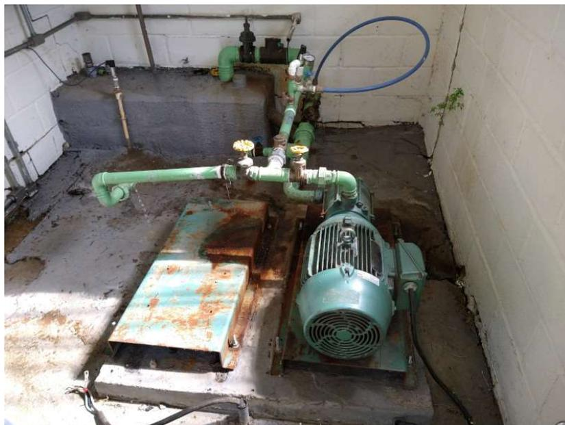
*Foto 30 Vista do conjunto motobomba do segundo estágio da captação*
