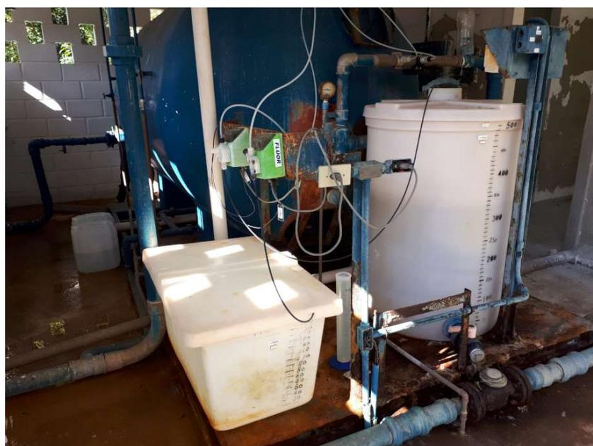
*Foto 33 Vista do filtro horizontal sob pressão e, em primeiro plano, sistemas de armazenamento e dosagem de hipoclorito de sódio e ácido fluossilícico*
