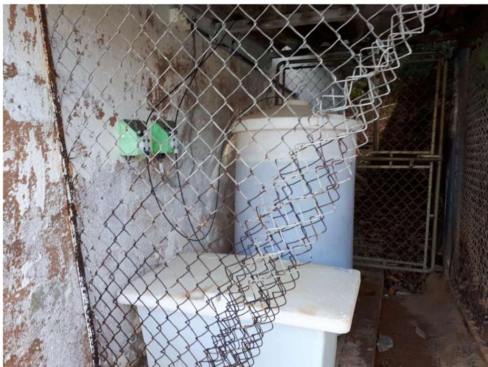
*Foto 24 Vista dos sistemas de armazenamento e dosagem de hipoclorito de sódio e ácido fluossilícico.*
