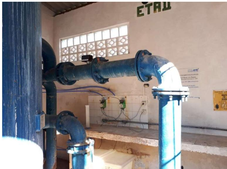
*Foto 27 Vista parcial do filtro da ETA II a sistemas de dosagem de hipoclorito de sódio e ácido fluossilícico*
