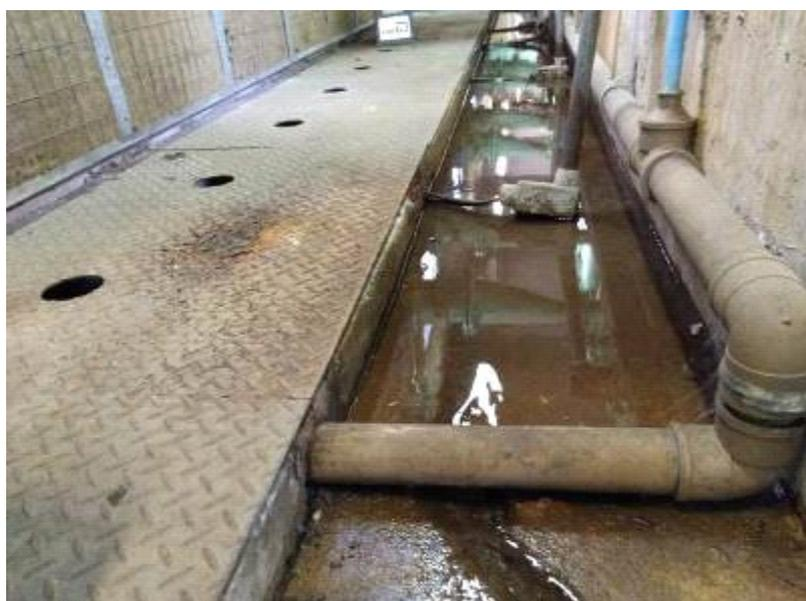
*Foto 39 EEA Diogo Fontes - Calha de cabos elétricos (440V) junto à calha de esgotamento de água*
