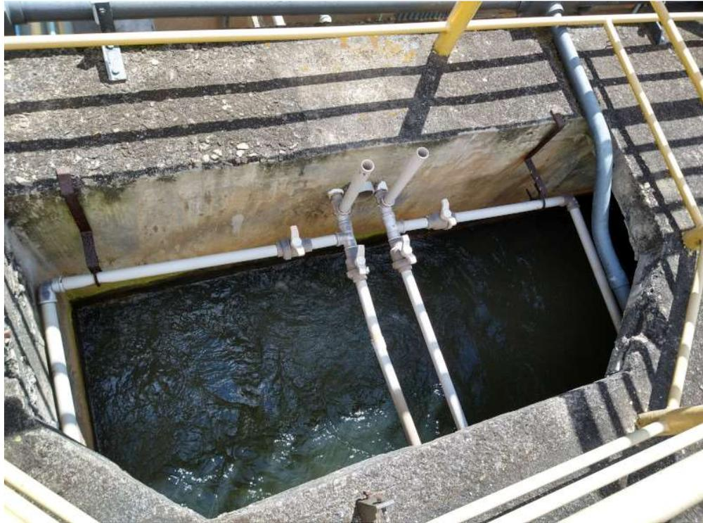
*Foto 6 Vista da estrutura de chegada de água bruta e tubulações de aplicação de produtos químicos*
