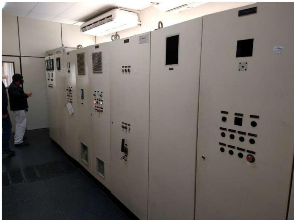
*Foto 5 Vista dos painéis de energização e comando dos conjuntos motobomba da captação principal.*
