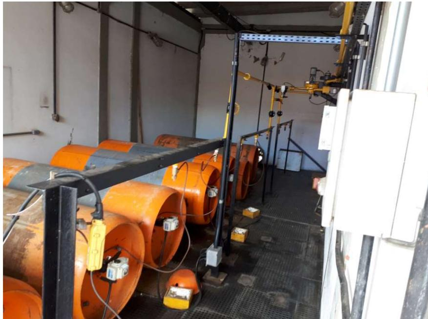
*Foto 13 Cilindros de 900 kg para o armazenamento do cloro gasoso*
