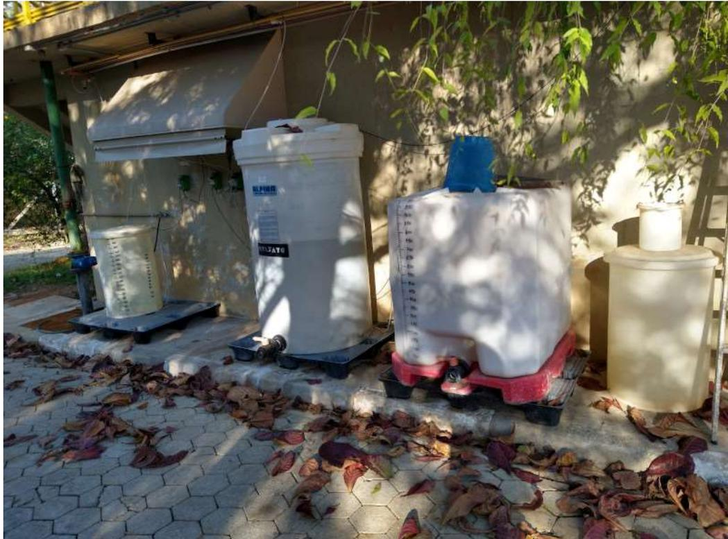
*Foto 18 Vista geral dos sistemas de armazenamenro e dosagem de produtos químicos: sulfato de alumínio, hipoclorito de sódio e ácido fluossilícico*
