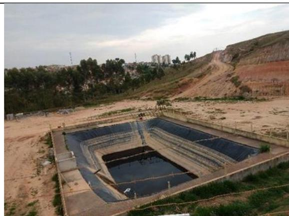
***Figura 66 aterro sanitário em operação - lagoa de estabilização do percolado (15/09/2021).***
