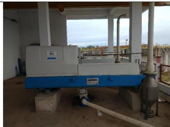
**Figura 90** Centrifugas utilizadas no desaguamento do lodo na ETE Central (16/09/2021).
