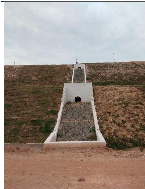
***Figura 65 aterro sanitário em operação - sistema de drenagem de água superficial (15/09/2021).***
