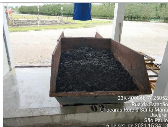
**Figura 92** Lodo desaguado na ETE Central
