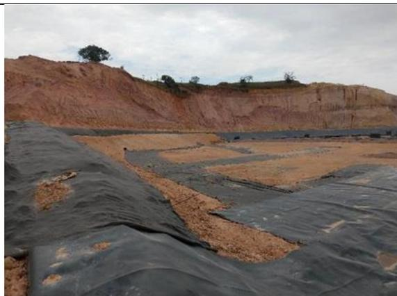
***Figura 63 aterro sanitário em operação – impermeabilização da base (15/09/2021).***
