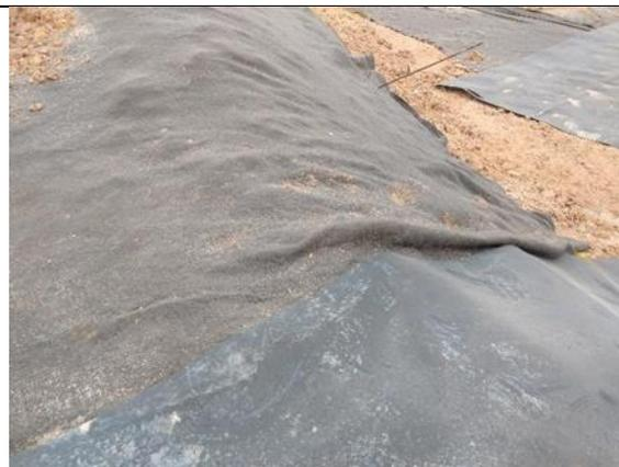
***Figura 64 aterro sanitário em operação – impermeabilização da base (15/09/2021)***
