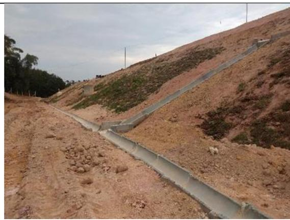
**Figura 60 aterro sanitário em operação - sistema de drenagem pluvial
