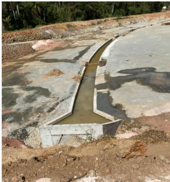
**Figura 92 – Canal no talvegeu da bacia de detenção**
