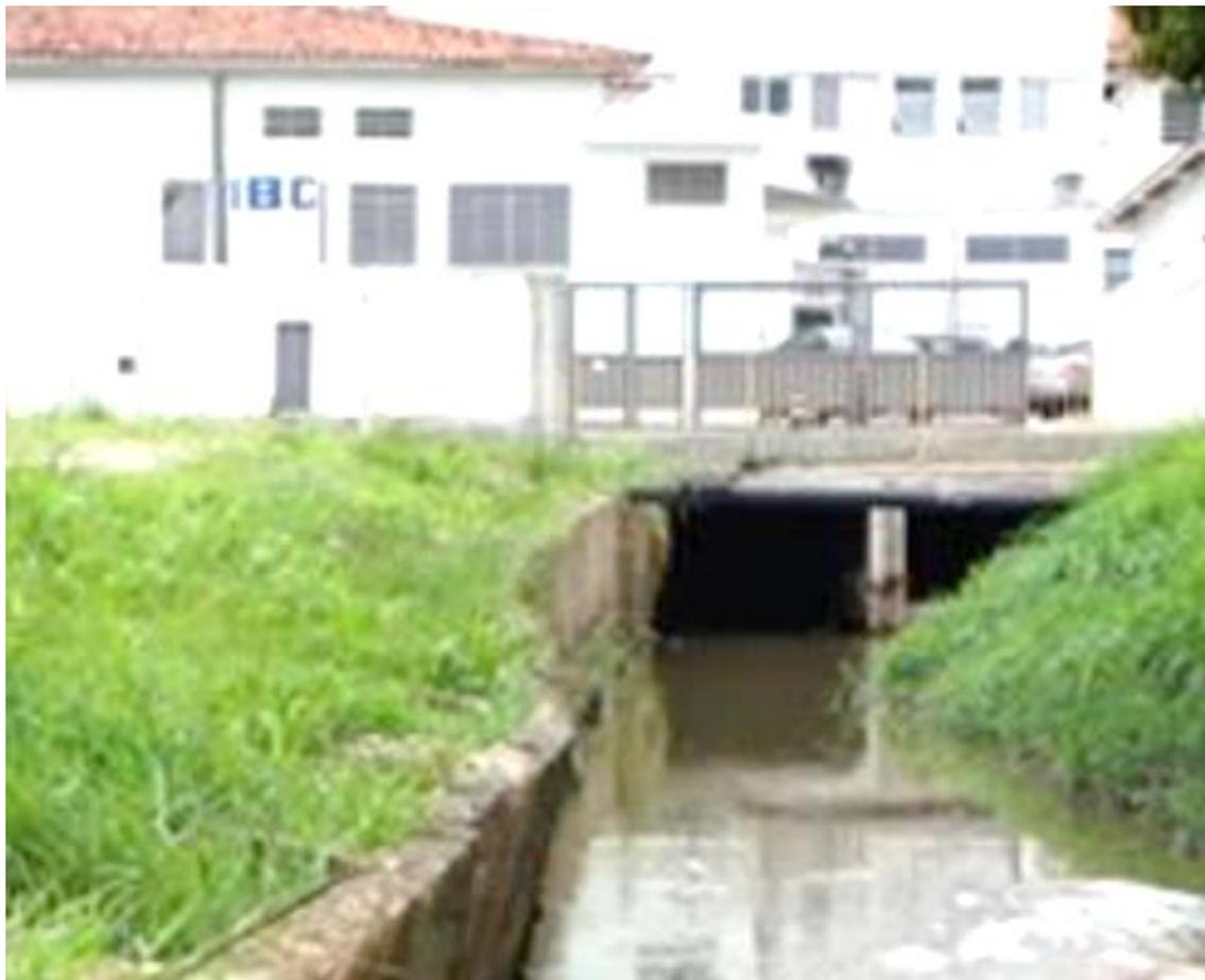
*Figura 17 - Rio Turi entrando em canal fechado - Note-se a parede central que obstrui a passagem*
