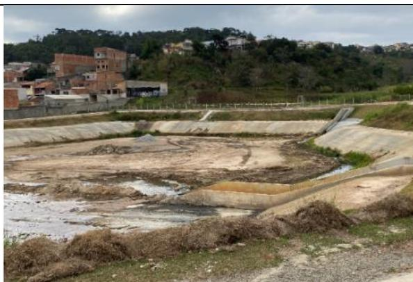
**Figura 97 – Reservatório de detenção**
