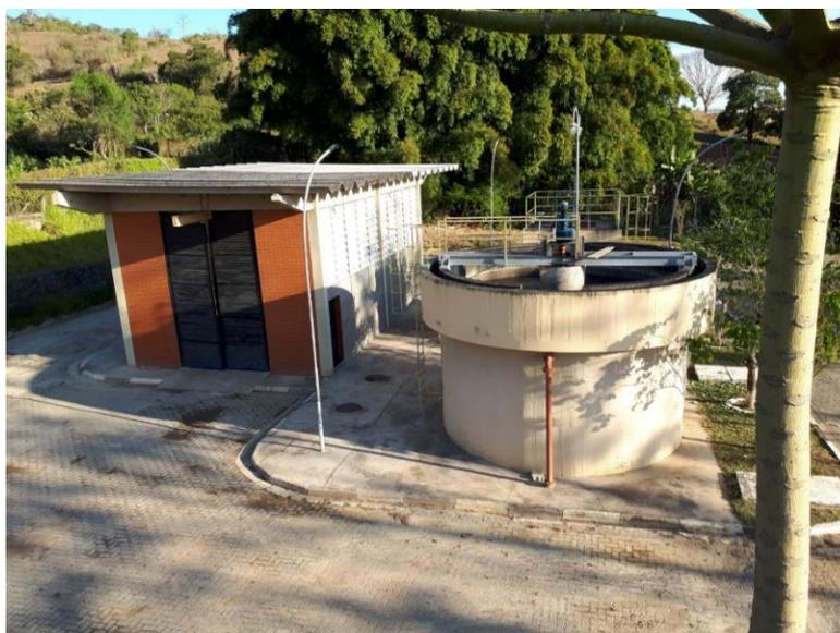
*Foto 22 Vista do adensador gravimétrico de lodo descartado e prédio do sistema de desaguentamento*
