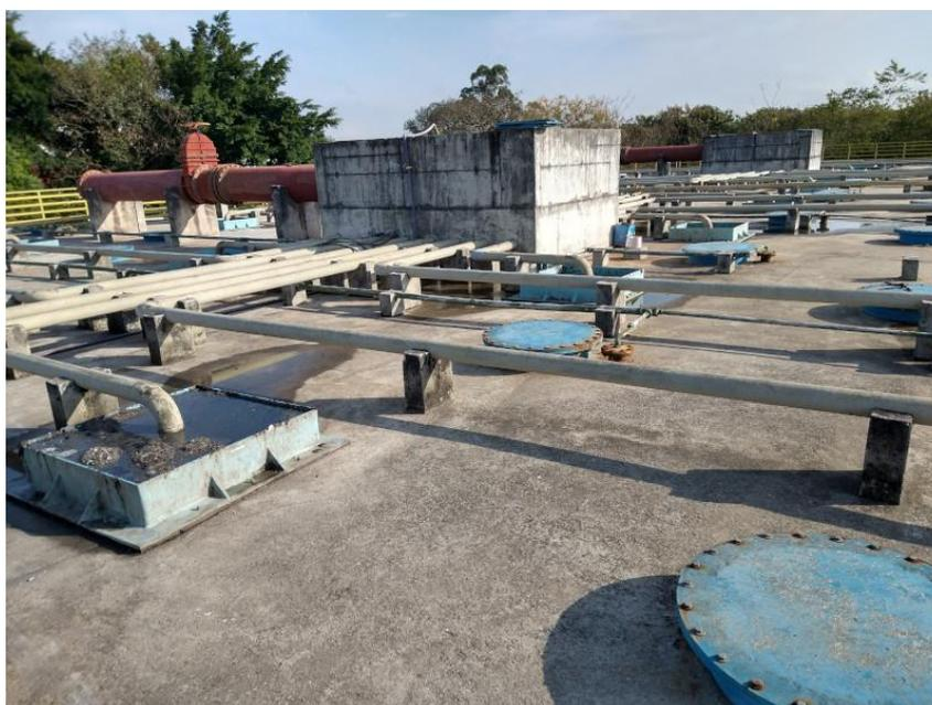
*Foto 2 Laje de cobertura de um reator UASB com destaque para as caixas de distribuição de fluxo de alimentação e inspeções*
