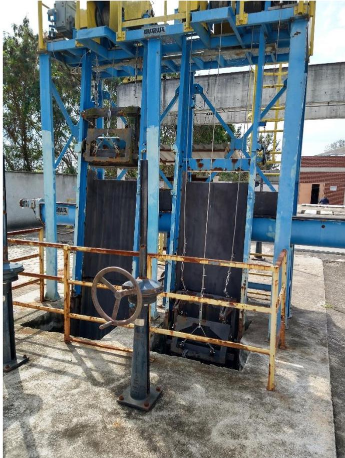
*Foto 32 Sistema de gradeamento mecanizado atualmente inoperante.*
