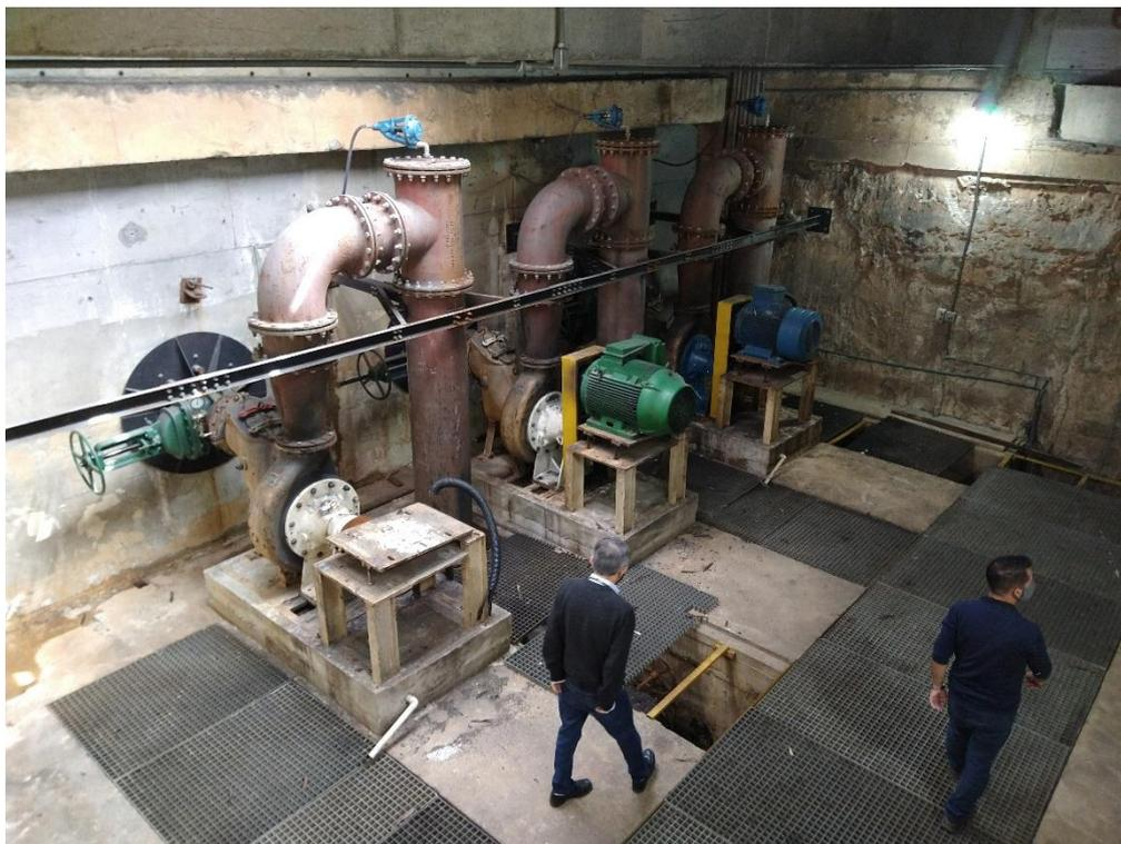
*Foto 34 Poço seco com os conjuntos moto bomba centrífugas de eixo horizontal.*
