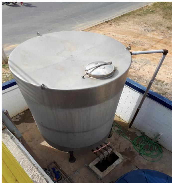
*Foto 29 Tanque de armazenamento de lodo descartado*
