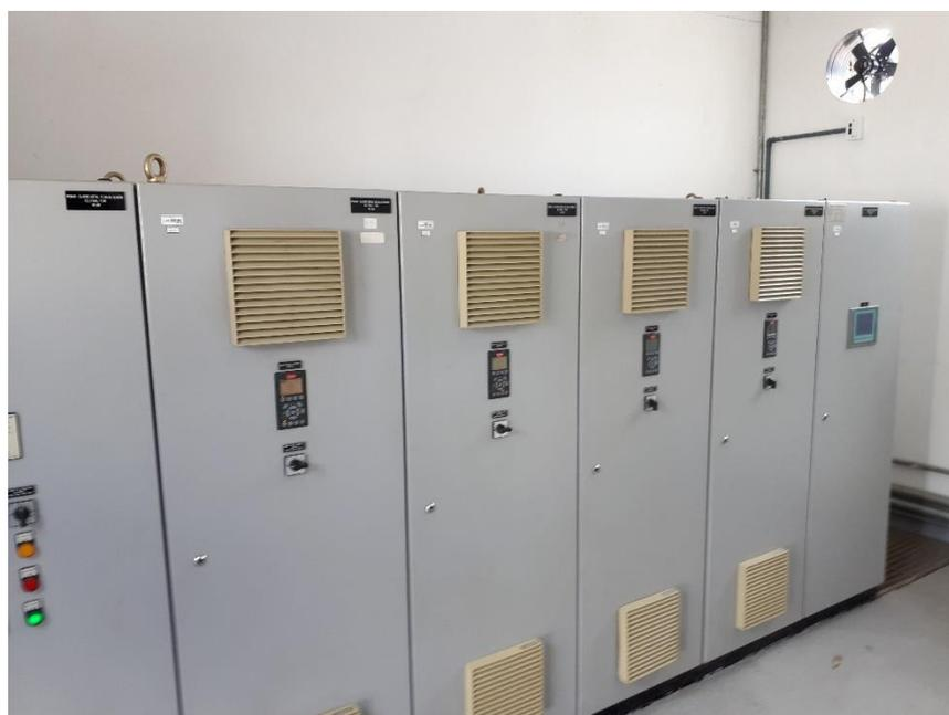
*Foto 35 Quadros elétricos de energização e comando*
