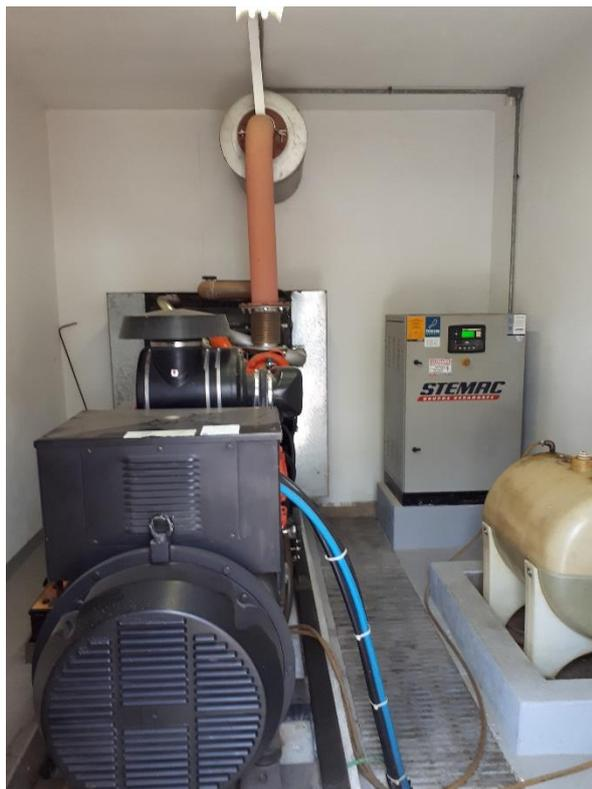
***Foto 36 Sistema de energização provisória. Gerador a diesel***
