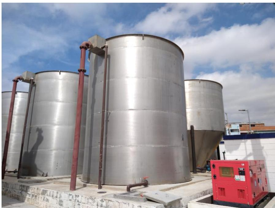
*Foto 27 Em primeiro plano, tanques de aeração e no segundo plano decantadores secundários. A direita, gerador destinado à eventual energização da EE de chegada do esgoto bruto*
