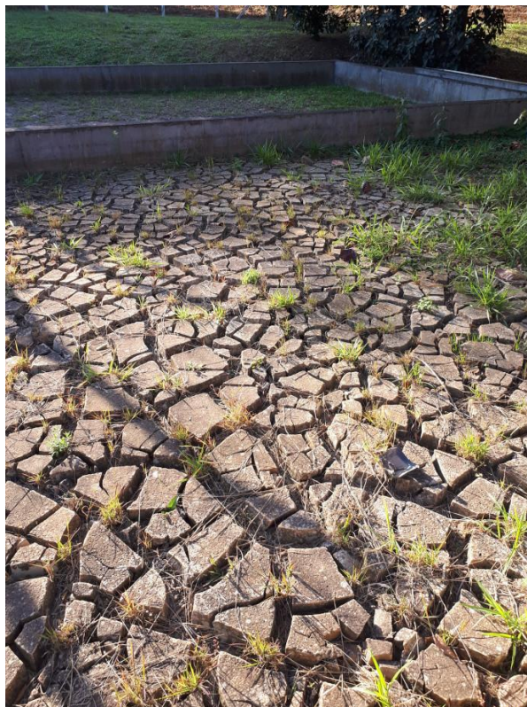
Foto 21 Vista dos leitos de secagem atualmente desativados
