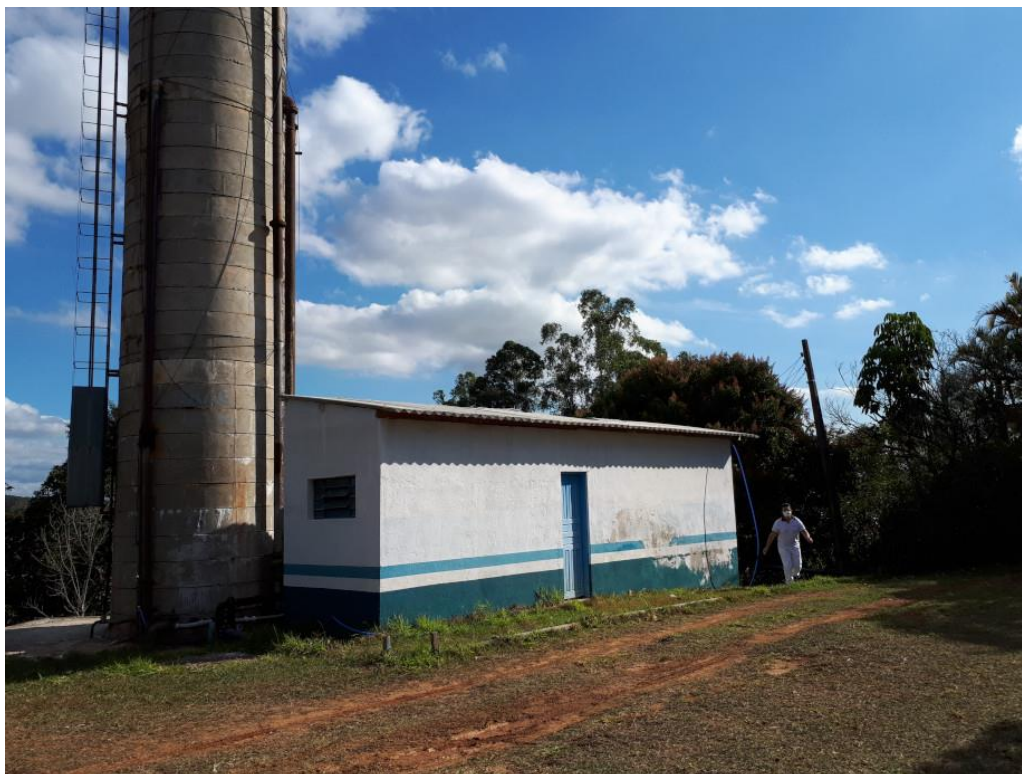
Foto 28 Vista da casa de abrigo da ETA II e, ao lado, o reservatório elevado de água tratada
