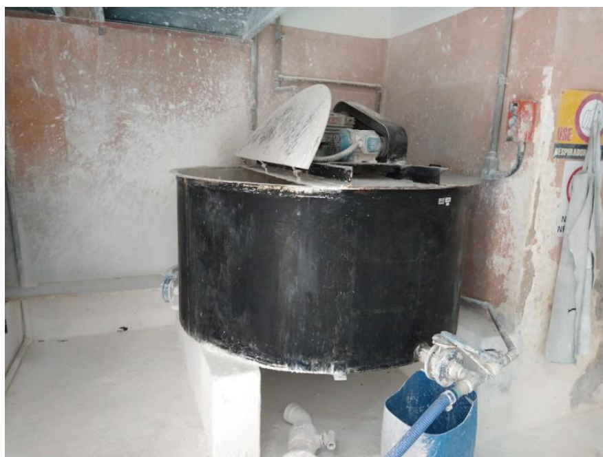
Foto 11 Vista de um dos preparadores de suspensão de cal hidratada
