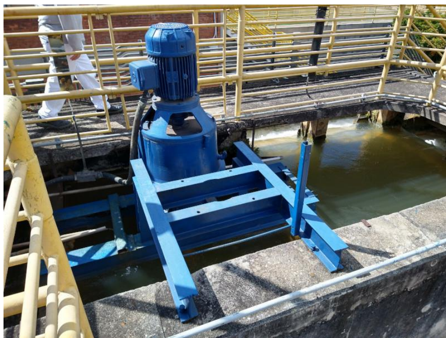
Foto 7 Vista de um dos floculadores mecânicos desativados
