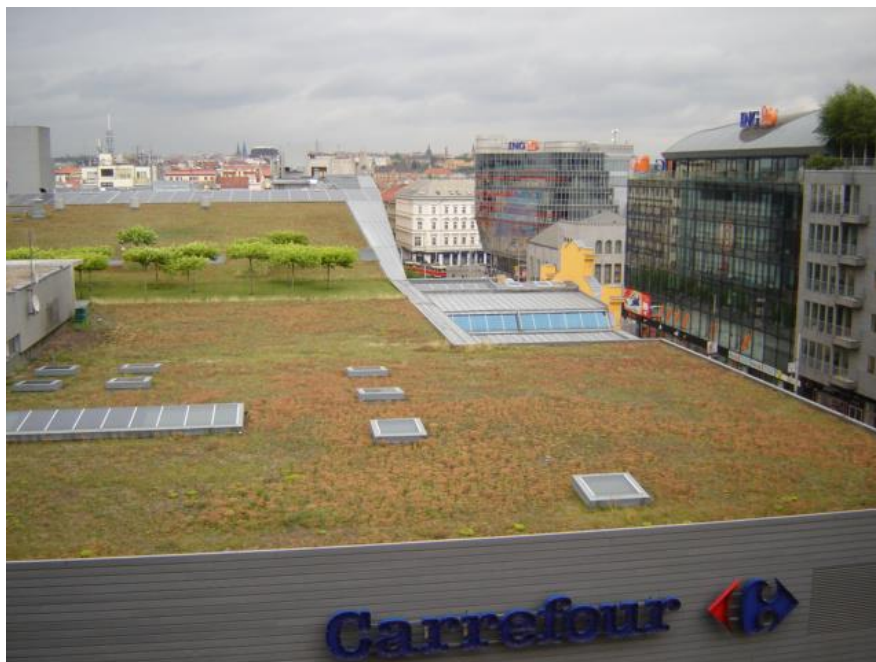
Figura 16 - Telhado verde do Carrefour em Viena, Áustria - Fonte: Dra. Cristina Bráulio, 2006, presidente da ABRASIP-Minas Gerais
