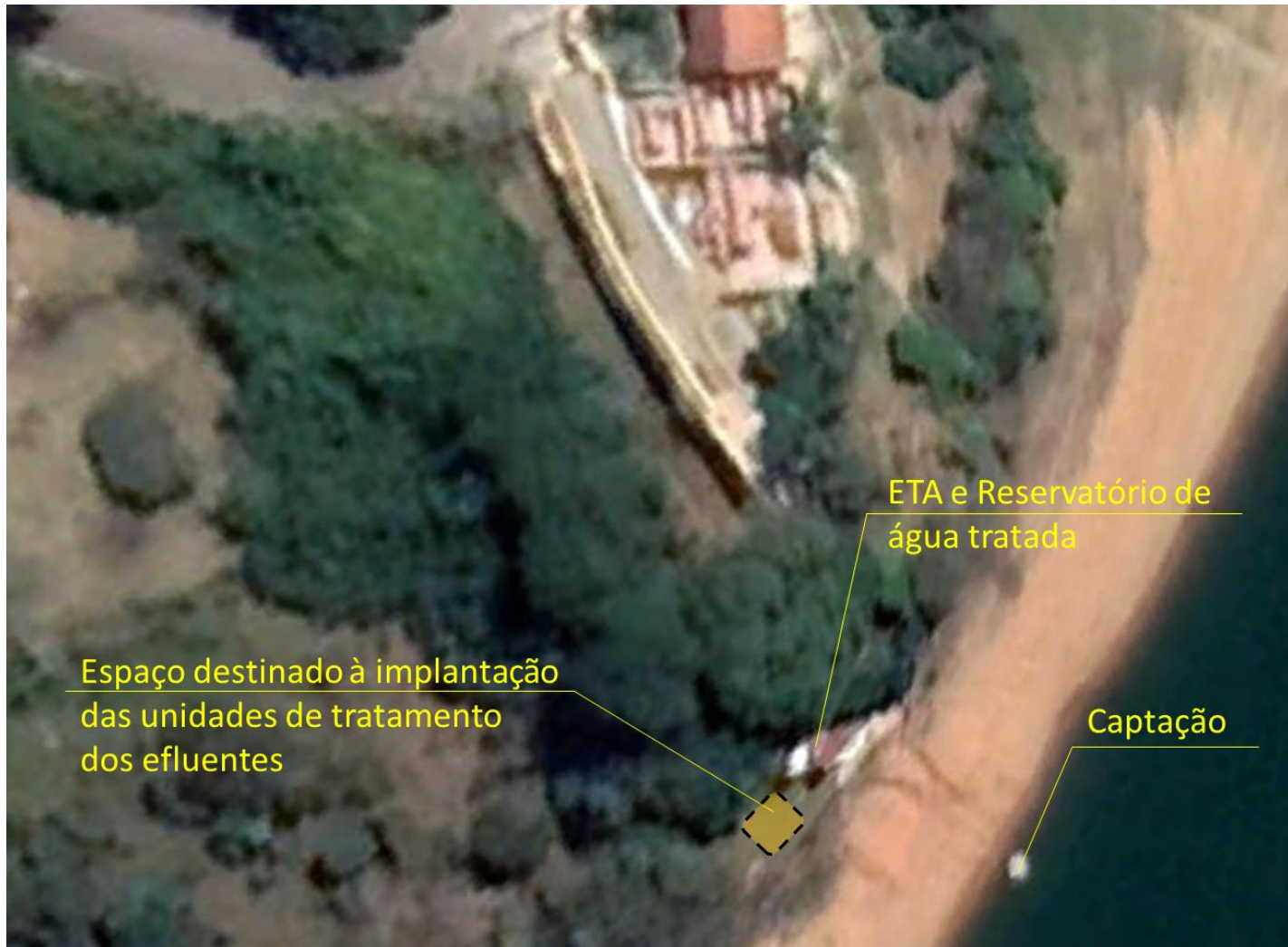
Figura 15 ETA I Possível local de implantação do sistema de tratamento dos efluentes
