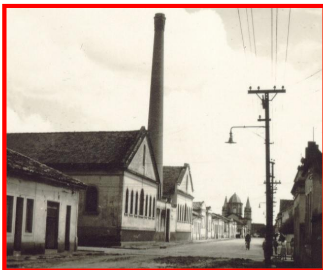
Figura 12 – Edificações próximas à linha férrea, na Praça Conde Frontin
