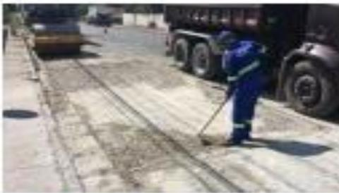
Foto 33 - Execução de Reforço do Pavimento
