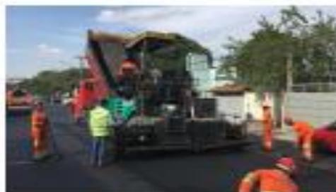
Foto 40 - Execução de Capa Asfáltica
