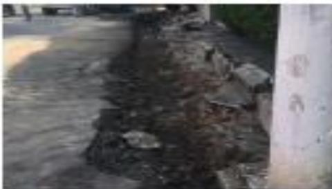
Foto 35 - Demolição de Guia e Sarjeta
