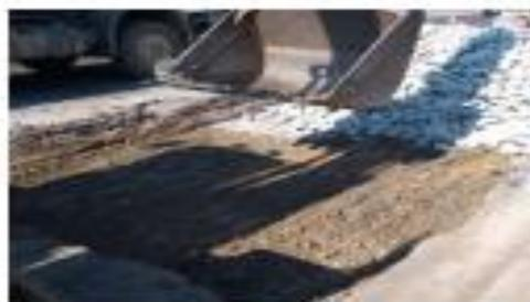
**Foto 30** - Execução de Reforço do Pavimento
