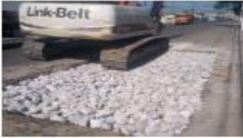
Foto 31 - Execução de Reforço do Pavimento
