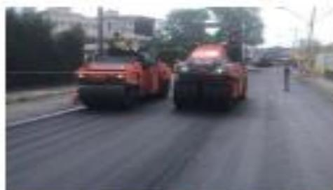
Foto 42 - Execução de Capa Asfáltica
