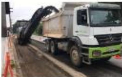
Foto 17 - Execução de Fresaagem
