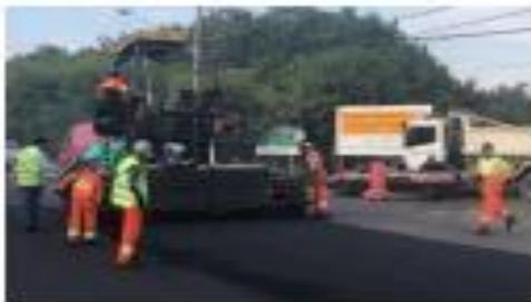
**Foto 47 - Execução de Capa Asfáltica**
