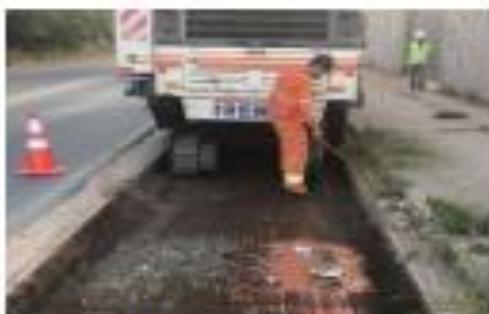
Foto 15 - Execução de Fresaagem
