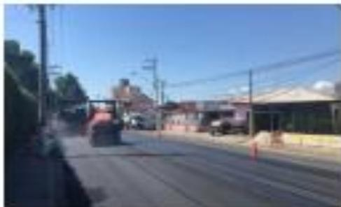
Foto 49 - Execução de Capa Asfáltica
