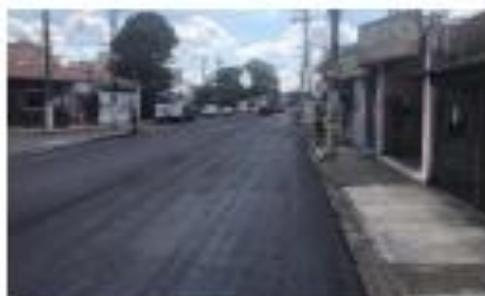
Foto 52 - Execução de Capa Asfáltica
