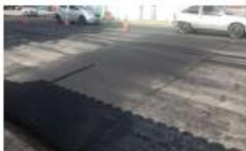
Foto 54 - Execução de Capa Asfáltica
