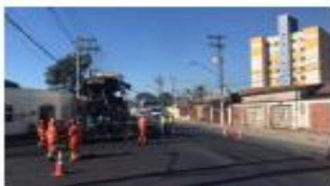
Foto 41 - Execução de Capa Asfáltica
