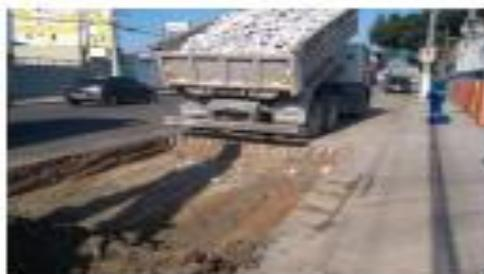
**Foto 29** - Execução de Reforço do Pavimento
