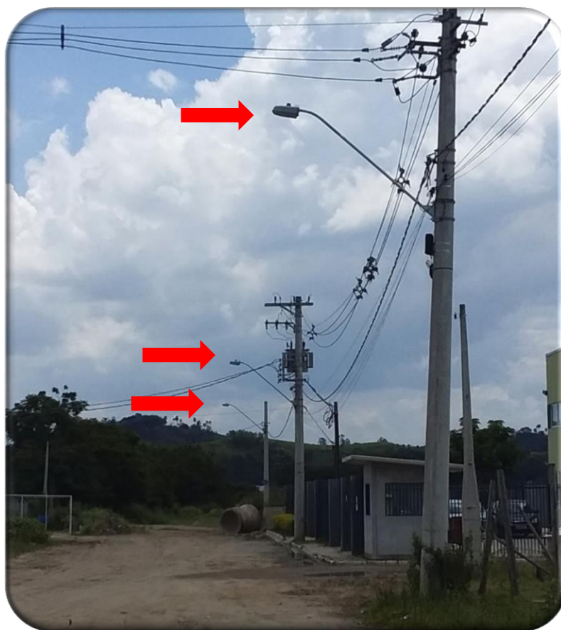
Figura 04: 03 Kits novos de iluminação de 150W – Av Industrial.
