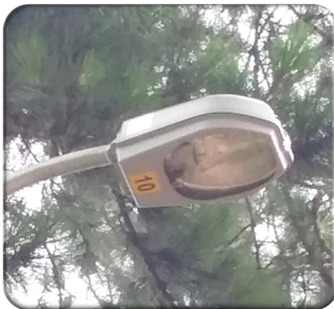
Figura 07: Detalhe de lâmpada de 100W/ vapor de sódio – Rua Nabuntino.
