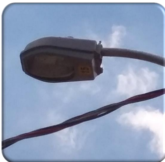
Figura 05: Detalhe de lâmpada de 150W/ vapor metálico – Av Industrial.
