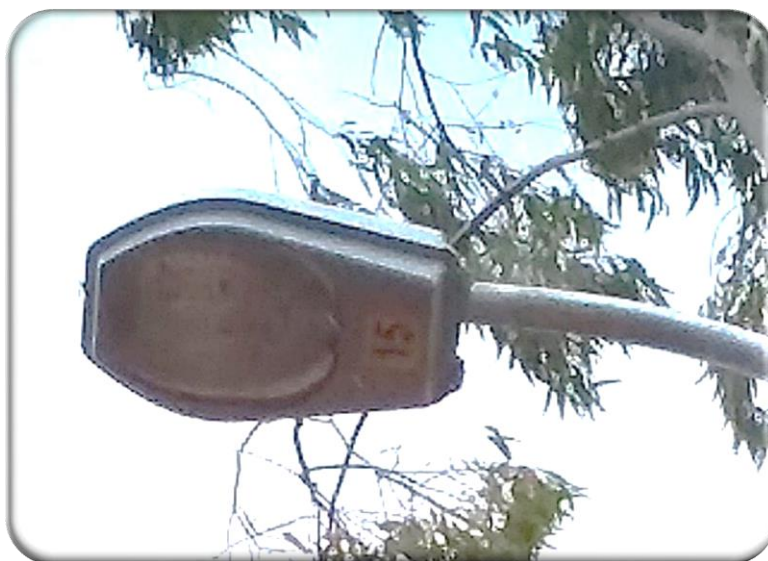
Figura 09: Detalhe do kit de iluminação de 150W/ vapor metálico – Rua Nabuntino.
