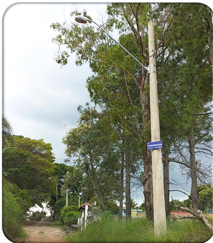
Figura 08: kit de iluminação de 150W/ vapor metálico – Rua Nabuntino.
