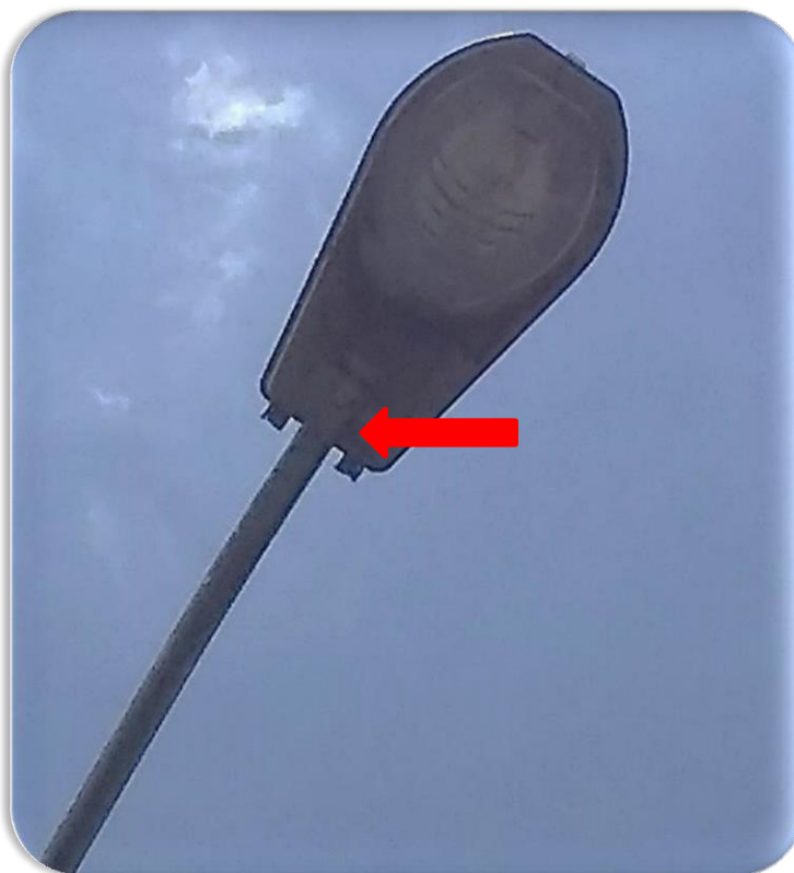
Figura 03: Lâmpada de 250W – Av Mississippi, 331.- Sem selo de identificação.
