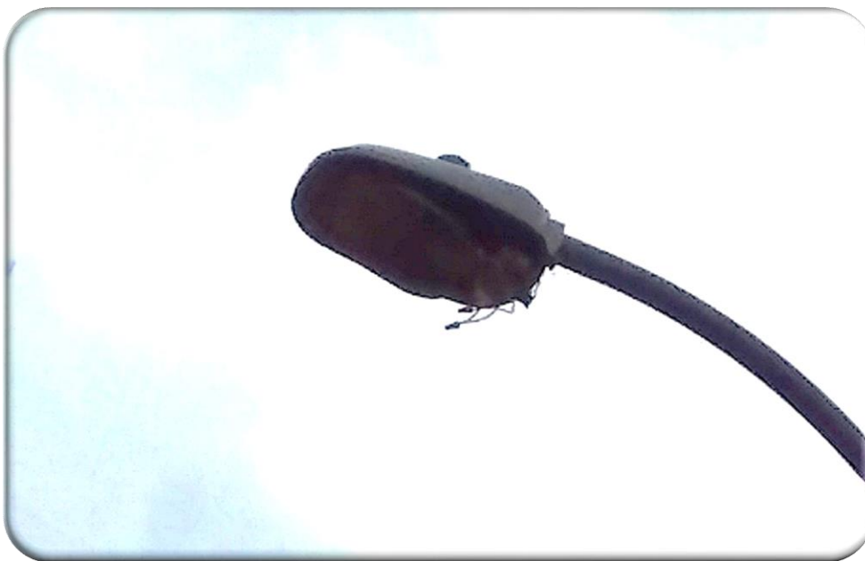
Figura 11: Detalhe do kit de iluminação avariado – Rua Augusto dos Anjos.
