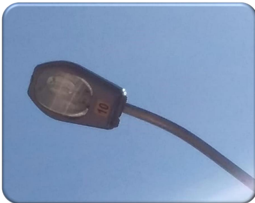
Figura 16: Detalhe da luminária nova em substituição à existente.
