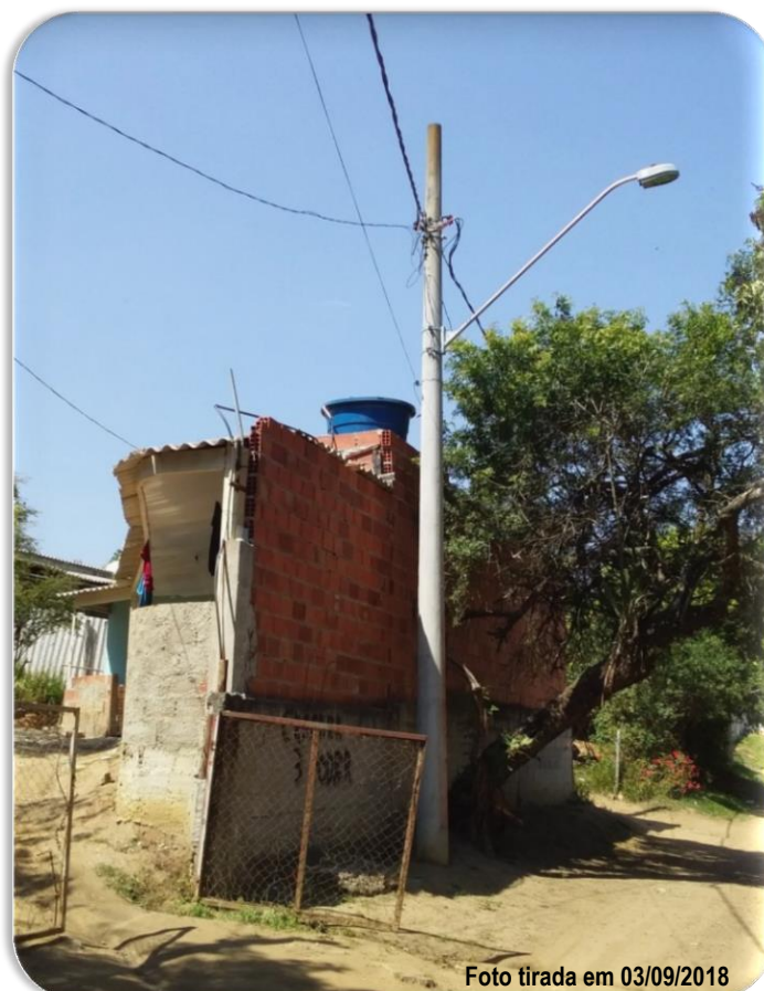
Figura 03: 2º poste com luminária nova - lâmpada de 100w - vapor de sódio.
