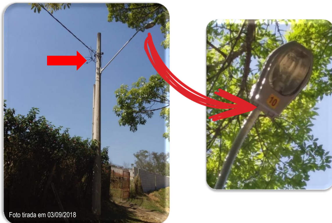
Figura 04: 3º poste com luminária nova - lâmpada de 100w - vapor de sódio - final da fiação.
