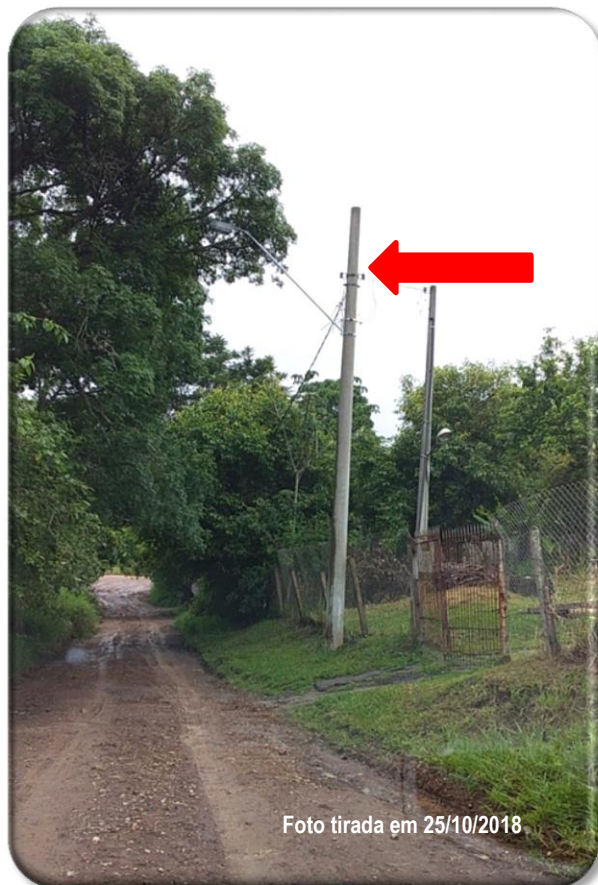
Figura 08: Imagem 3º poste, ultimo poste existente na rua 2.
