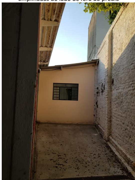
Foto 29: Almojarifado Educação – lateral do prédio sem vedação entre o teto, muro e local onde está depositado o cloro
