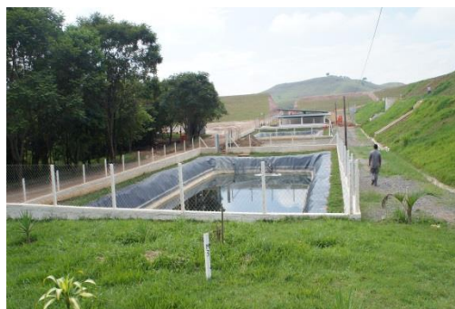
Foto 06 – Estação de pré-tratamento de chorume
