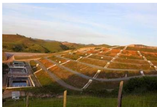
Foto 04 – Rede de drenagem do aterro sanitário
