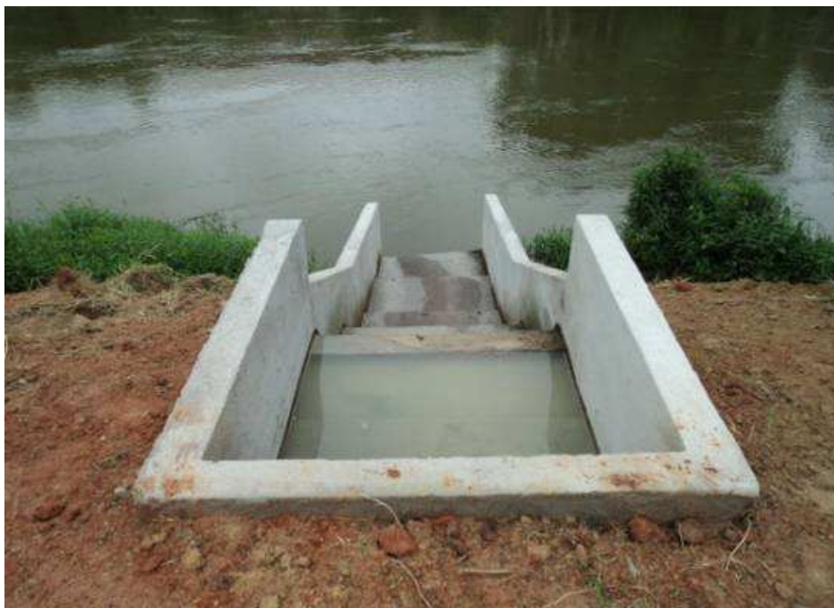
Foto 41 – Lançamento do efluente tratado no Rio Paraíba do Sul - ETE São Silvestre.
