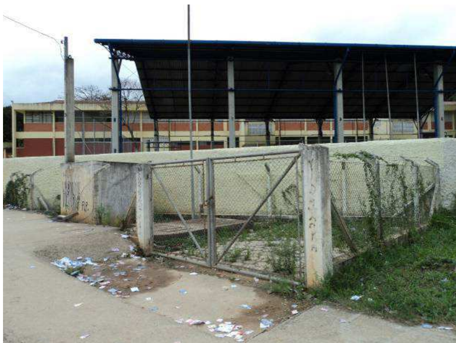
Foto 21 – Estação Elevatória de Esgotos EEE 29.
