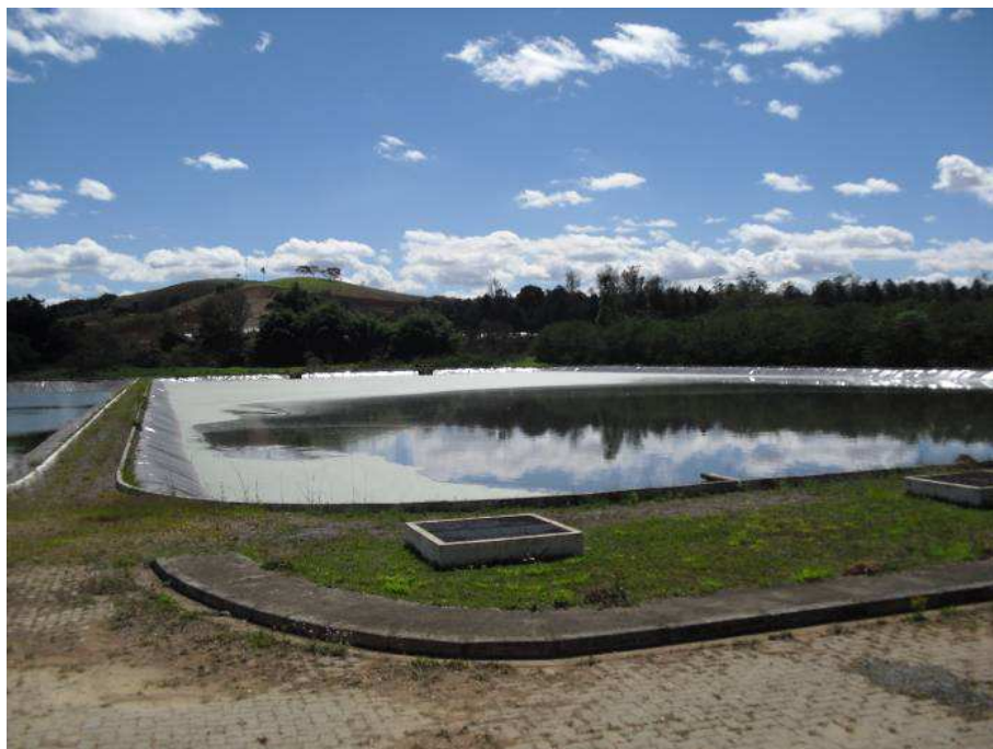
Foto 39 – Lagoa facultativa da ETE São Silvestre.
