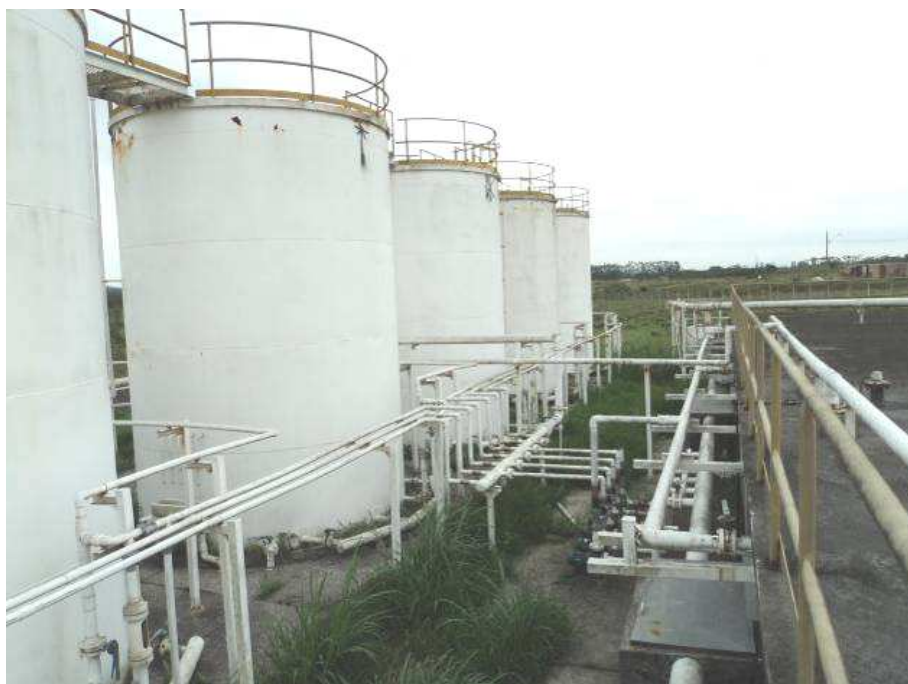
Foto 23 – Detalhe da ETE Parque dos Sinos.
