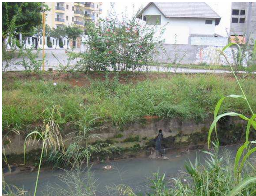
Foto 10 – Lançamento na margem direita, da rede coletora – Rua Enéas de Mesquita. (Fonte: Cobrape-Gerentec)
