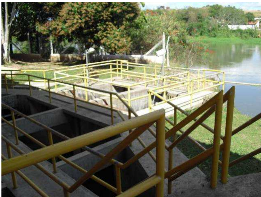
Foto 01 – Captação Superficial no Rio Paraíba do Sul.
