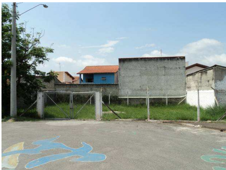
Foto 14 – Estação Elevatória de Esgotos EEE 2.
