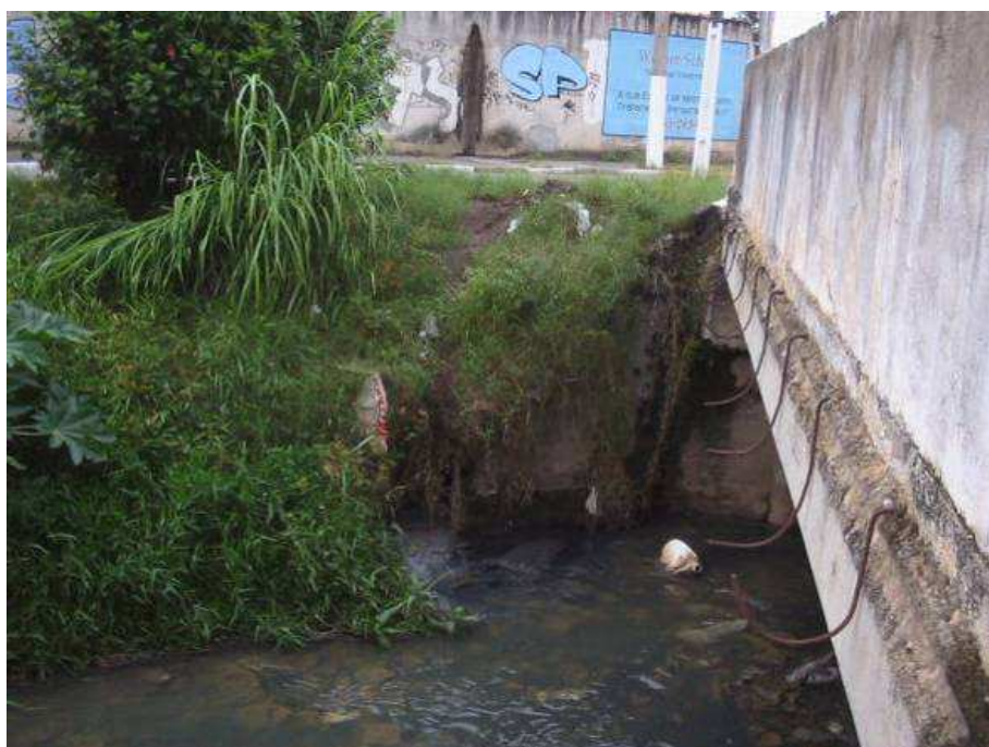
Foto 09 – Lançamento, na margem esquerda, da rede coletora – Avenida 9 de Julho. (Fonte: Cobrape-Gerentec)
