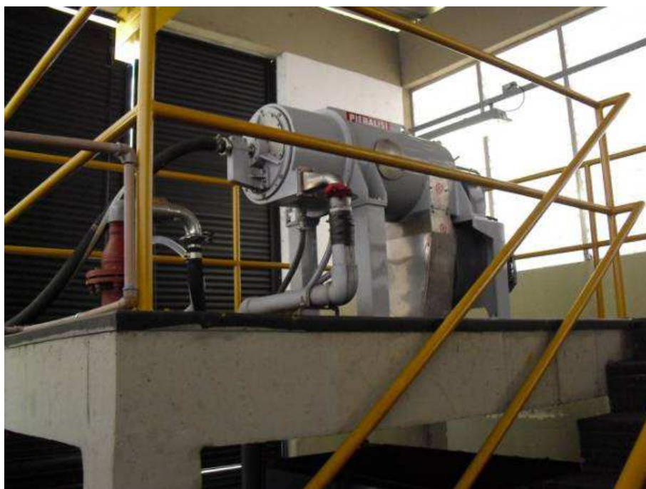
Foto 31 – Centrífuga de lodo da ETE Bandeira Branca.
