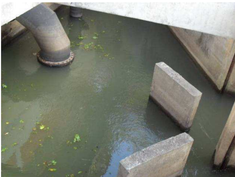
Foto 02 – Captação Superficial no Rio Paraíba do Sul.
