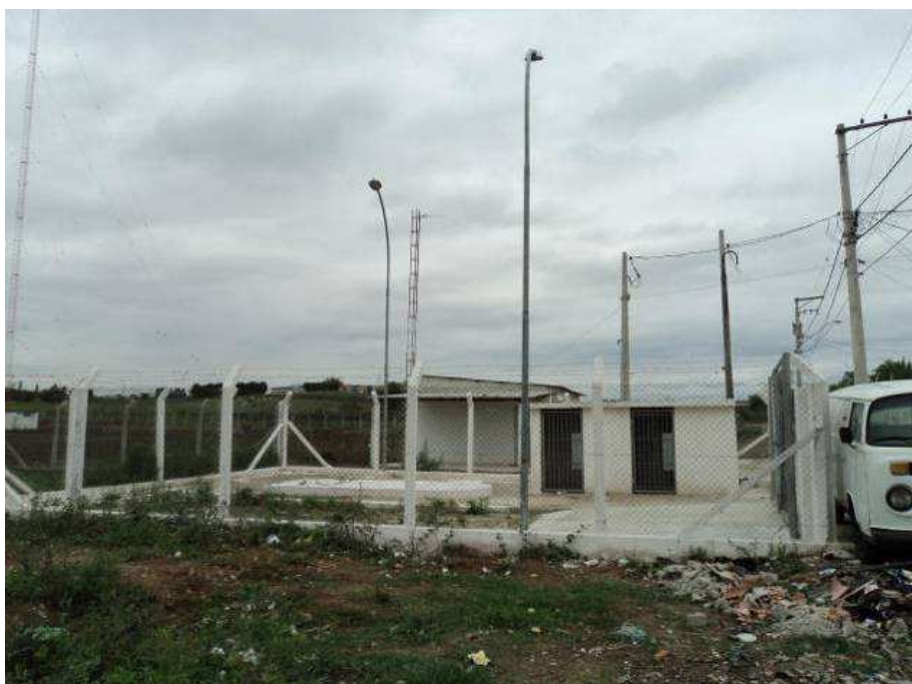
Foto 26 – Estação Elevatória de Esgotos – EEE 32 – Jd. Conquista.
