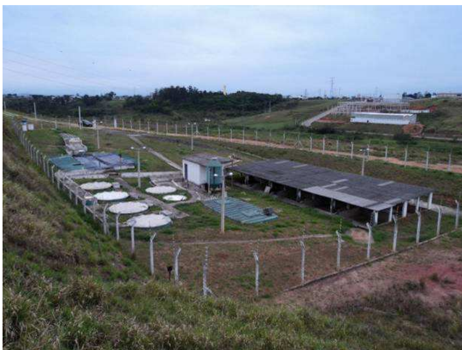
Foto 42 – ETE do Loteamento Santa Paula.
