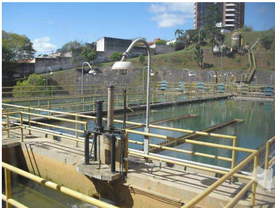
Foto 04 – Vista geral da ETA Central de Jacareí.
