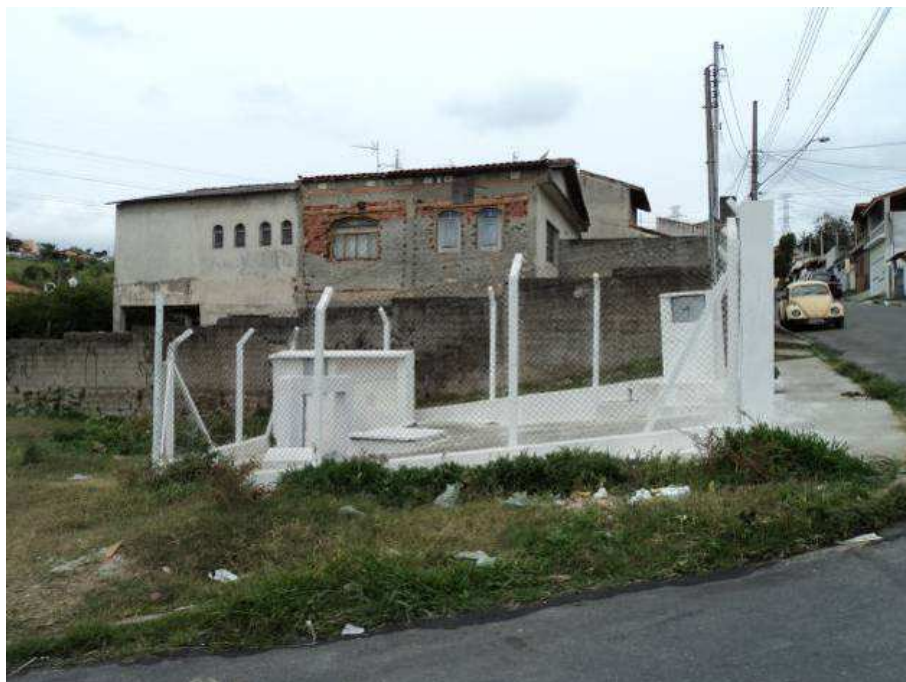
Foto 13 – Estação Elevatória de Esgotos EEE 1.
