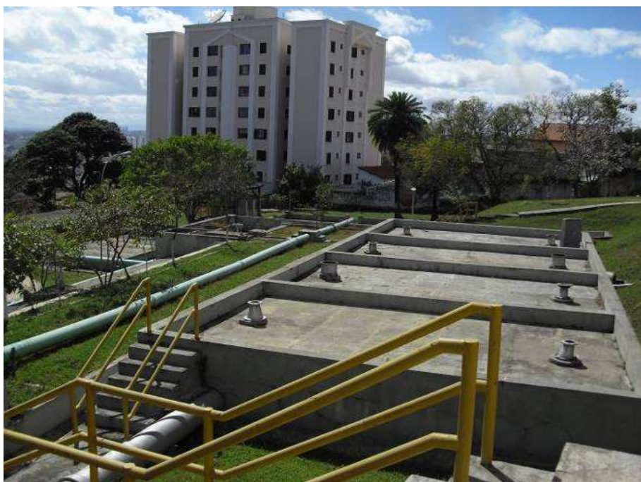
Foto 05 – Vista geral da ETA Central de Jacareí.
