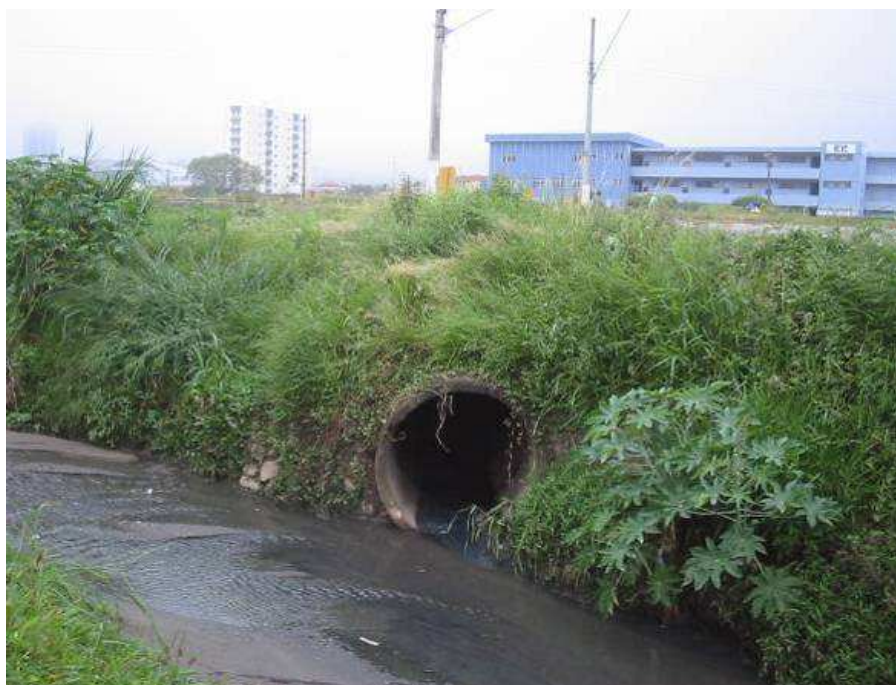
Foto 11 – Lançamento da rede coletora da Avenida Prefeito José C. Arouca no Rio Turi, margem esquerda (Fonte: Cobrape-Gerentec)
