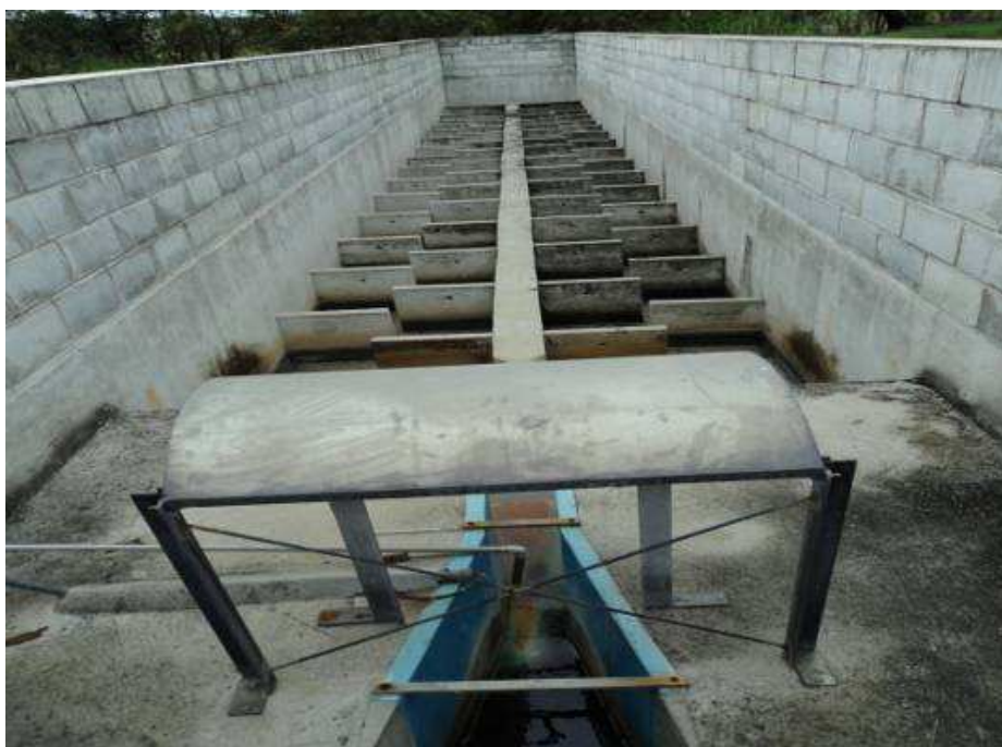
Foto 40 – Tanque de contato da ETE São Silvestre.
