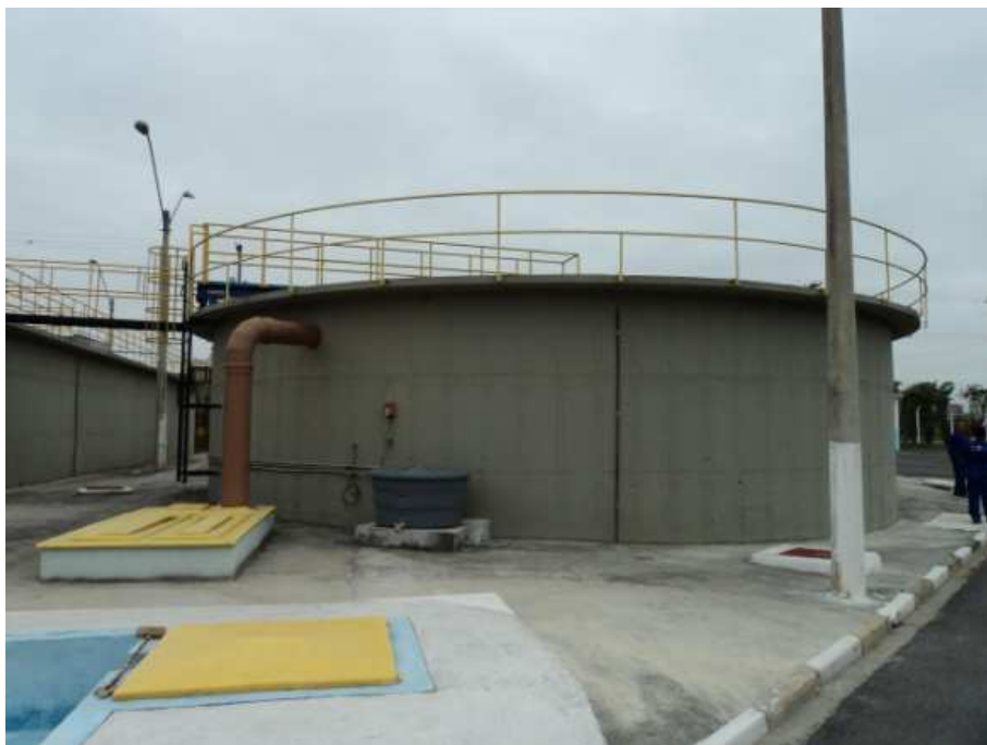
Foto 37 – Decantador da ETE Vila Branca.
