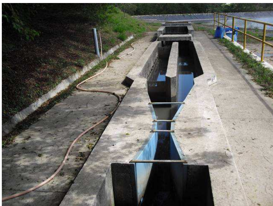
Foto 38 – Chegada de esgoto bruto na ETE São Silvestre.
