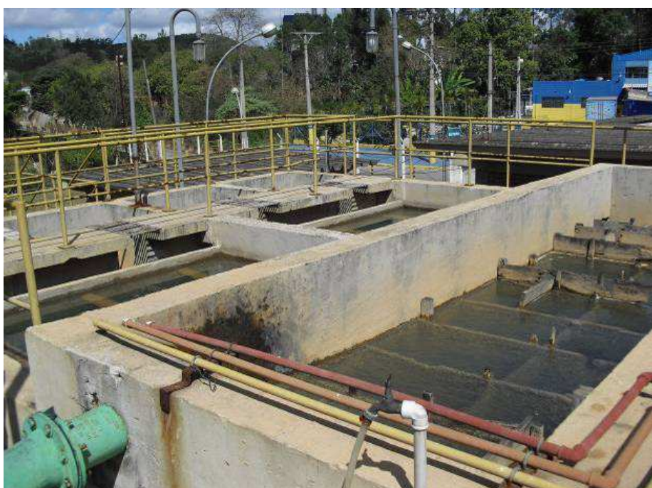
Foto 07 – Vista geral da ETA São Silvestre.
