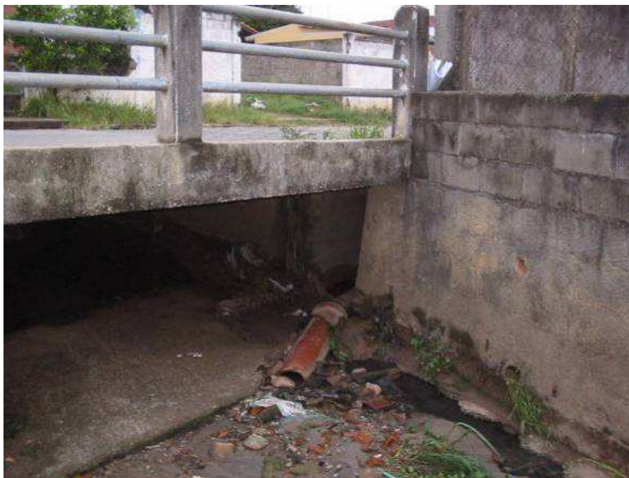
Foto 12 – Lançamento da rede coletora da Rua Mariana. (Fonte: Cobrape-Gerentec)
