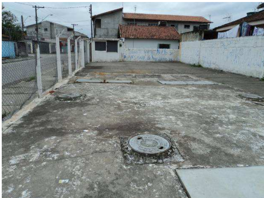
Foto 15 – Estação Elevatória de Esgotos EEE 3.
